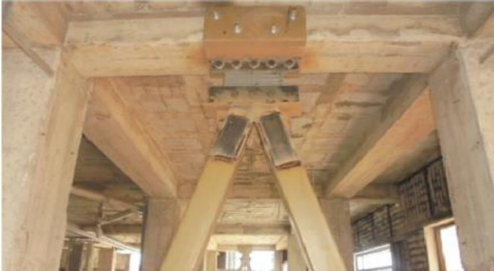
*Figura 3. Disipador metálico colocado en arreglo Chevron en el hotel Ceibo Dorado, después de la ocurrencia del sismo de Ecuador del 2016.
