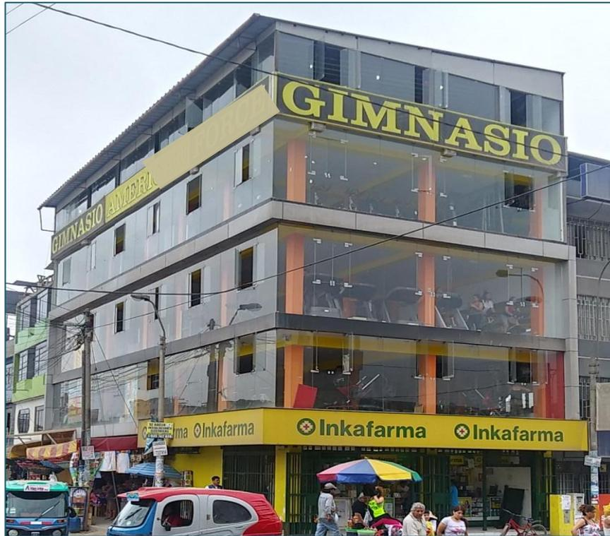
Figura 16. Edificación de cinco de niveles de pórticos de concreto armado, ubicada en Villa El Salvador.
