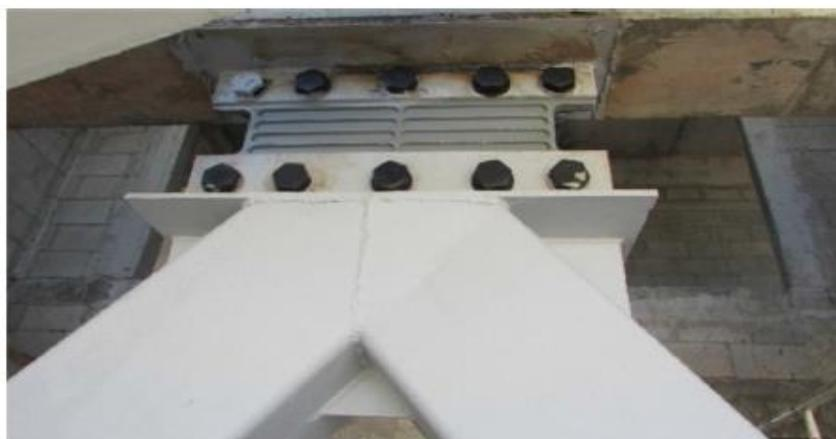
Figura 2. Detalle de la instalación de un disipador metálico SLB, en la torre Ixtapa (México).
