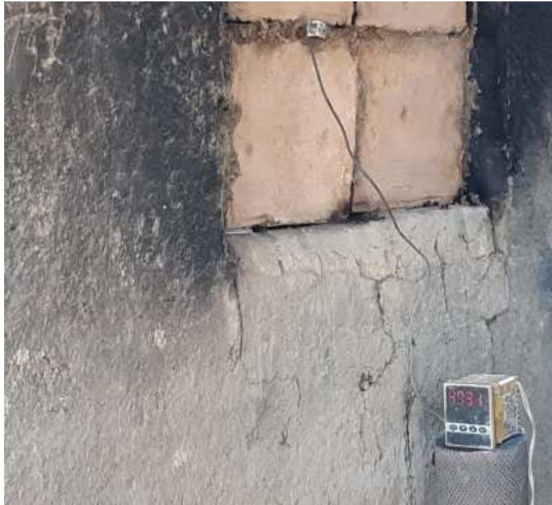
Ilustración 13. Pirómetro marcando la temperatura del horno
