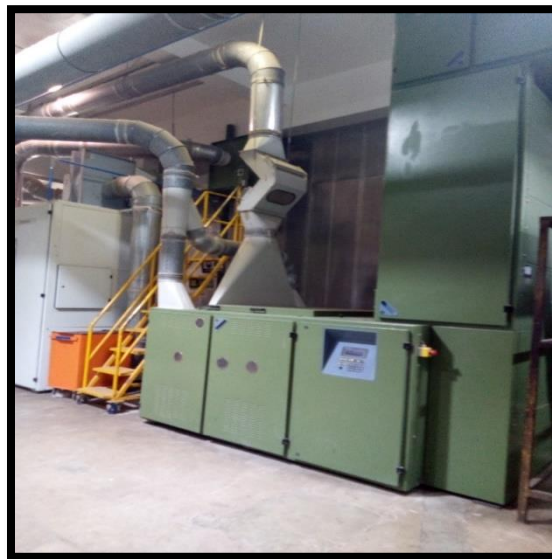
Figura 34: Zona de Limpieza del área de Hilandería
