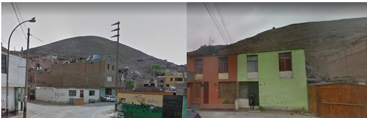
Figura 55: Vista de las viviendas aledañas al cerro Mulería
