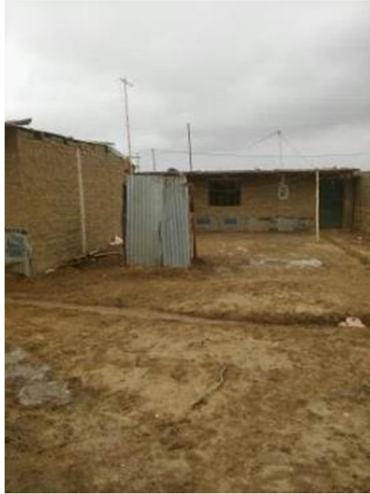
Foto N° 3 Vista de un pozo ciego
