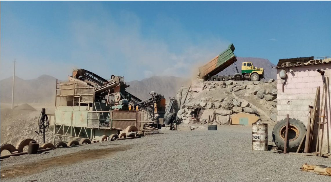
Vista interior de la cantera Gutiérrez.
