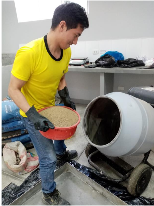
Preparación de la mezcla de concreto en el trompo mezclador.
