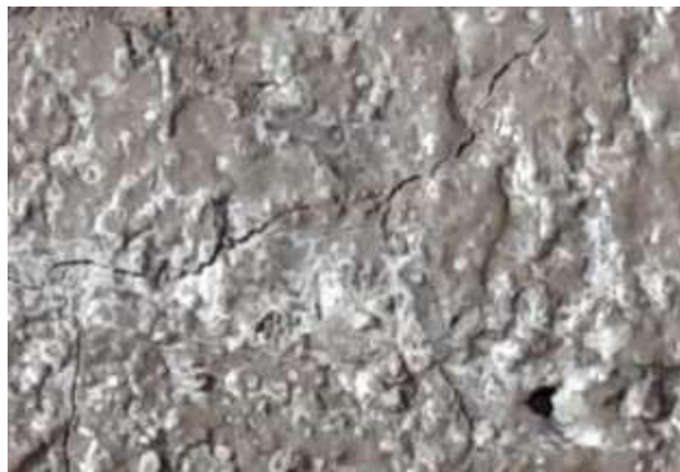
Figura 1. Fisuración por contratación plástica Fuente: Jauregui Guerra (2019)
