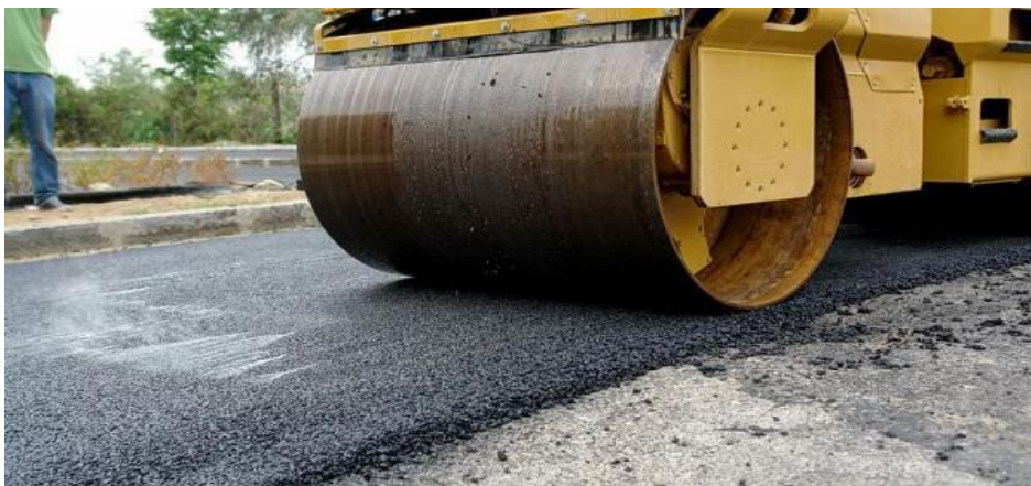
Figura 2. Aplicación del caucho en pavimentos flexibles
