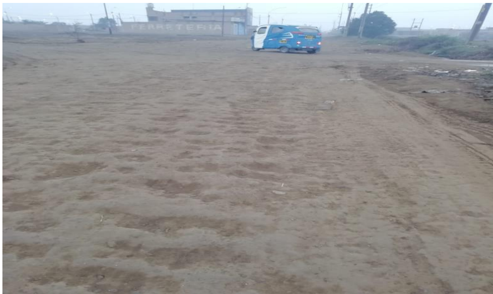
Figura 8. Avenida Bonavista a nivel de subrasante
