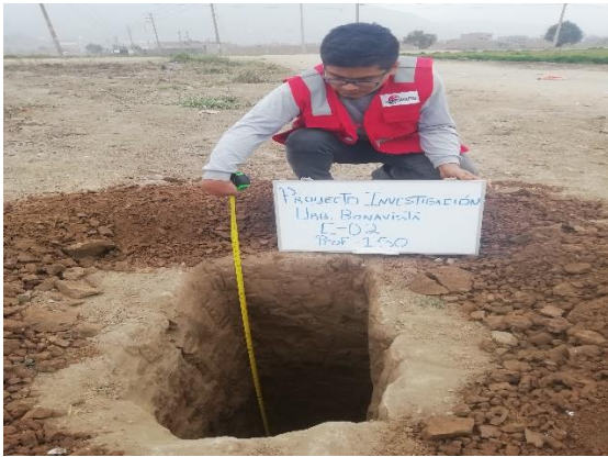
Figura 40. Excavacion de calicata y muestreo
