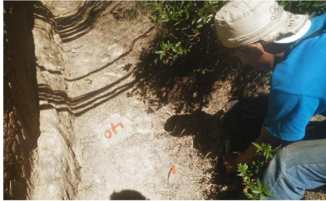
FOTO N°3.- ESTACADO DE LINEA DE CONDUCCION
