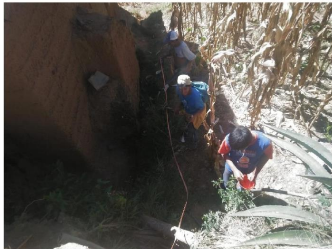
FOTO N°4.- MEDICION DE LINEA DE DISTRIBUCION, ESTACADO CADA 20 METROS
