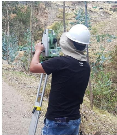
FOTO N°6. - LEVANTAMIENTO TOPOGRAFICO CON ESTACION TOTAL
