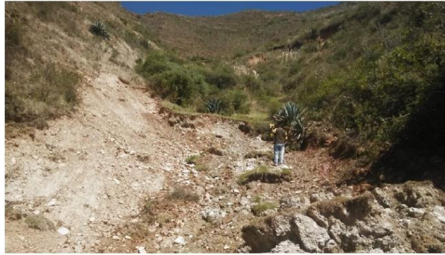
FOTO N°11.- LEVANTAMIENTO TOPOGRAFICO CON ESTACION TOTAL, CAPTACION
