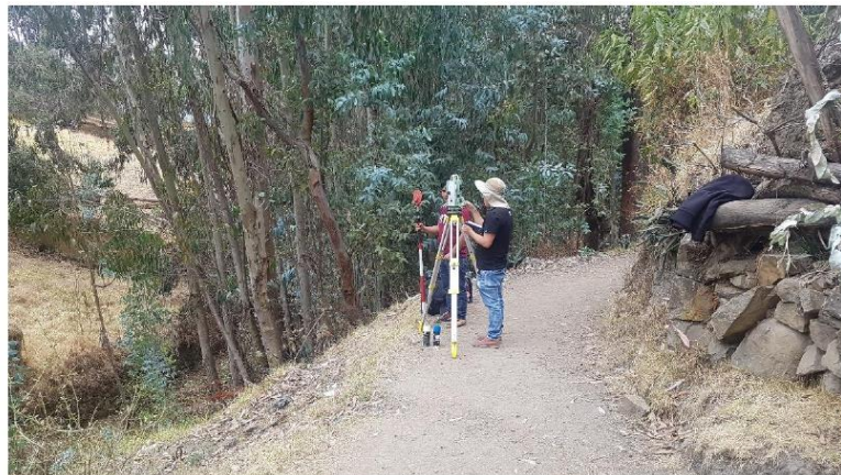
FOTO N° 10.- INSTALACION DE ESTACION TOTAL
