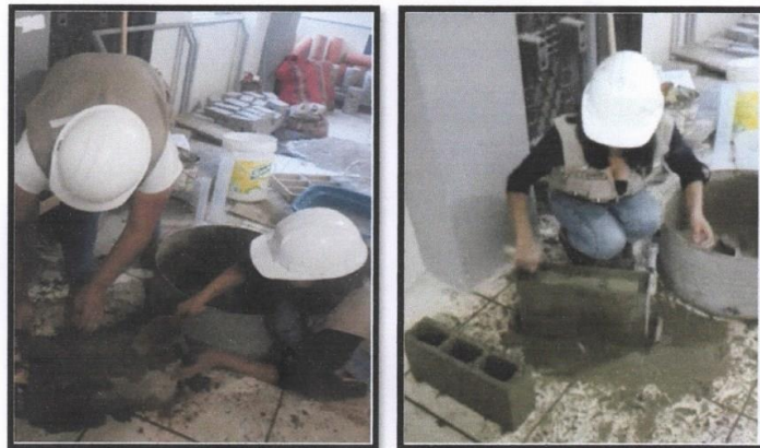
Fotografía 7 y 8: Llenar el molde del bloque con la mezcla, con dos capas de igual volumen, cada capa debe ser compactada con 25 golpes.
