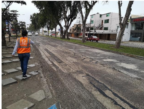
Figura 6: Pavimento Rígido de av. El Ejercito cdra. 18
