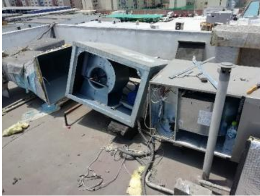
Ilustración 19: Siroco, bomba de condensado y pruebas de funcionamiento
