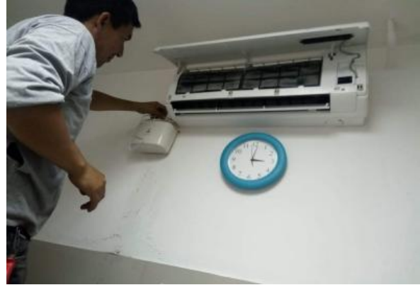
Ilustración 19: Siroco, bomba de condensado y pruebas de funcionamiento
