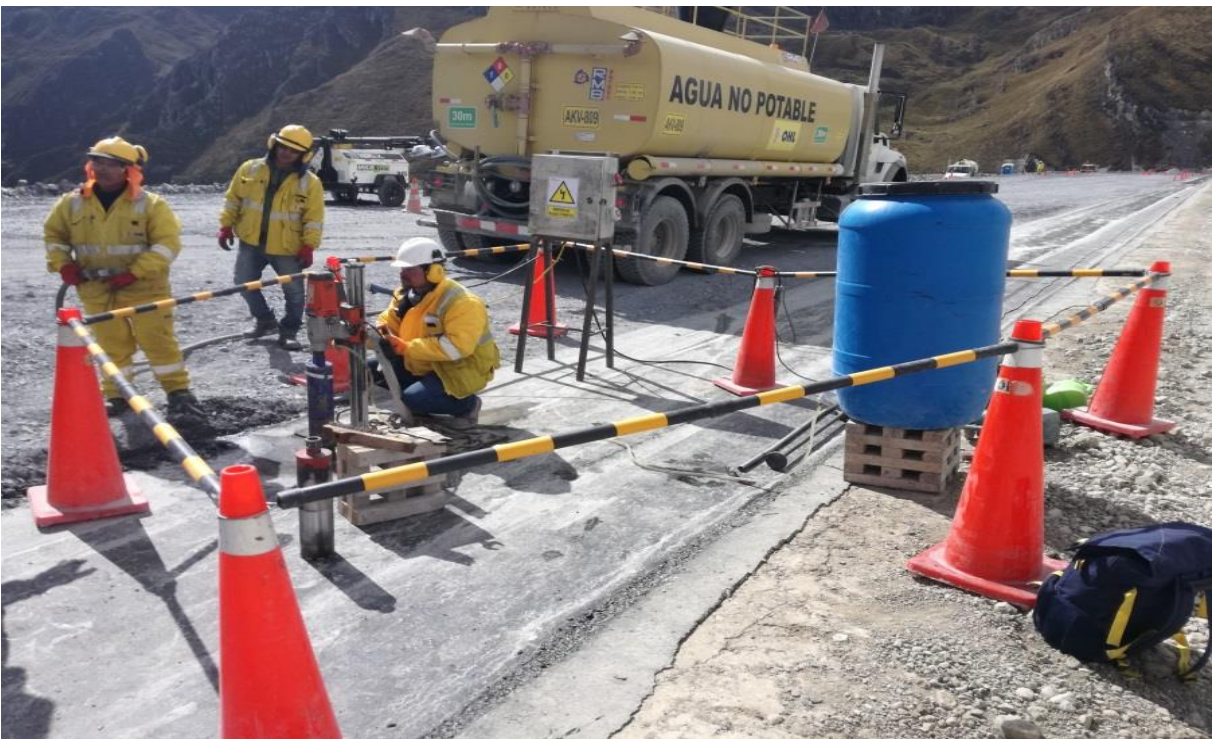
Figura 49: Extracción de los núcleos de asfalto para determinar el % de vacíos, fuente elaboración propia.
