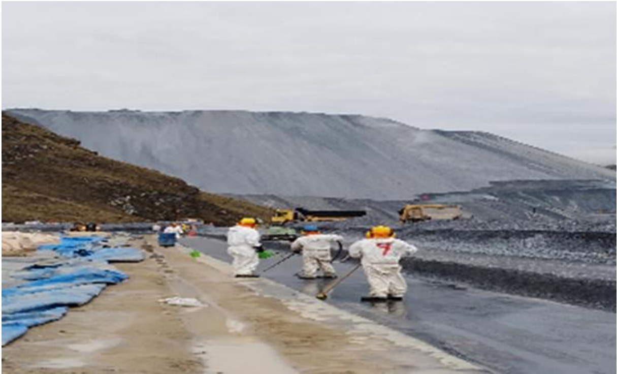
Figura 44: Limpieza del área a asfaltar en la presa de relaves, fuente elaboración propia.
