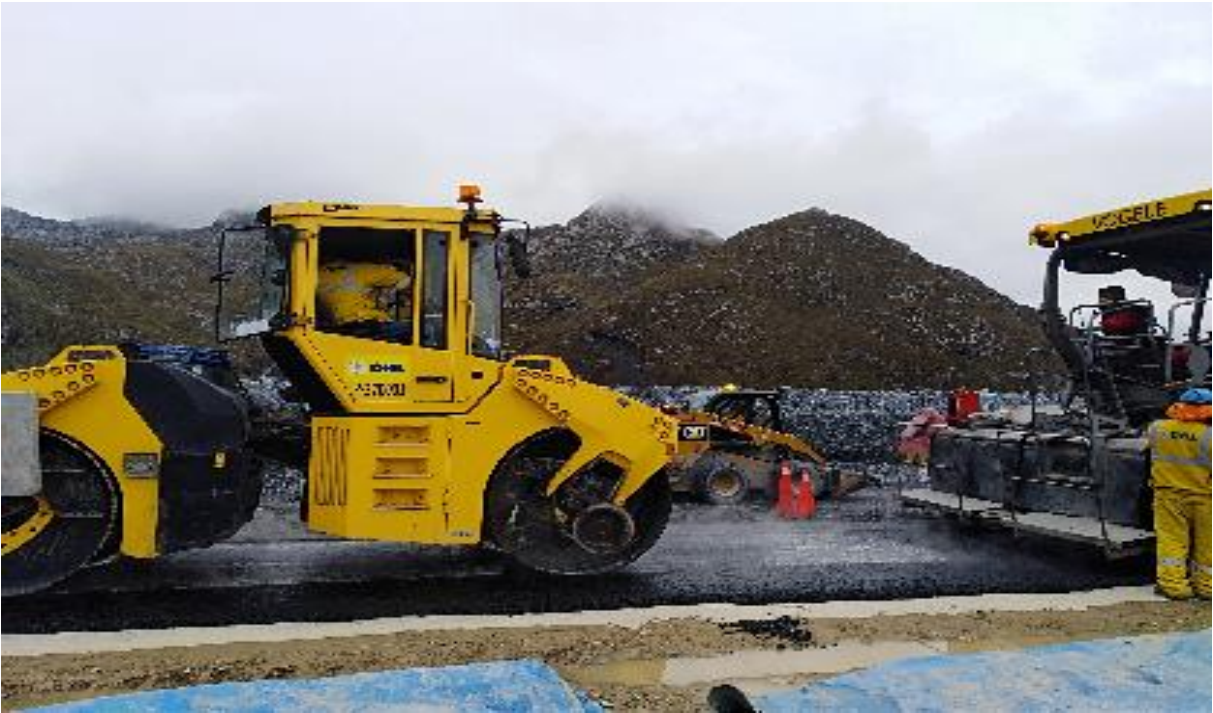
Figura 46: Colocado y compactado de la mezcla asfáltica en la presa de relave, fuente elaboración propia.
