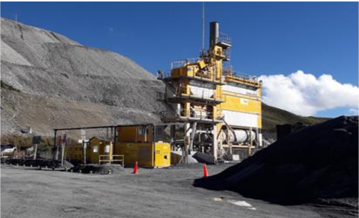
Figura 42: Vista de la Planta de Asfalto, fuente elaboración propia.
