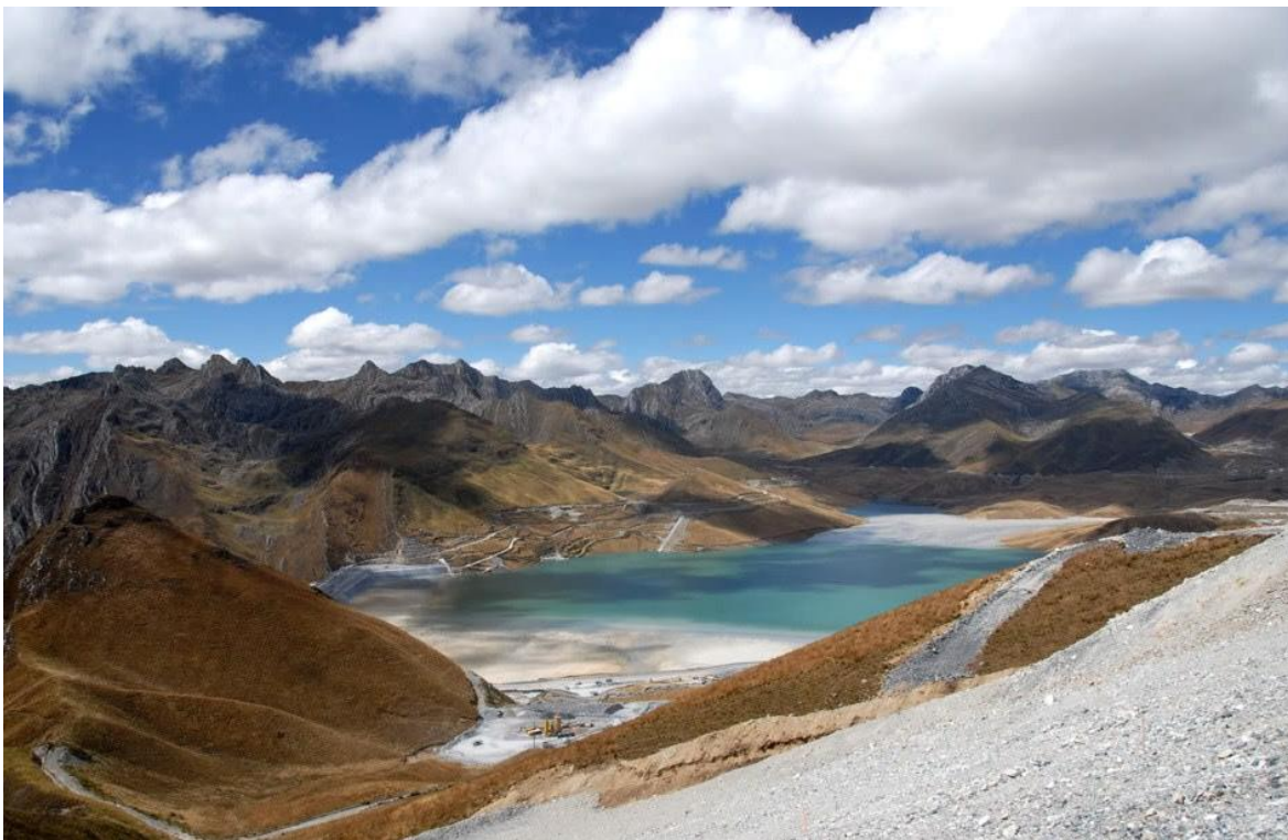
Figura 9: Vista panorámica de la presa de relaves, fuente elaboración propia.
