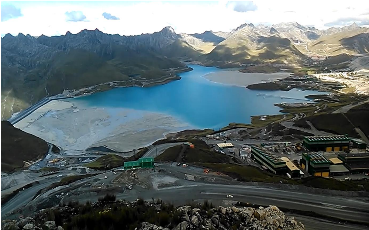
Figura 2: Vista de la presa de relaves, fuente elaboración propia.
