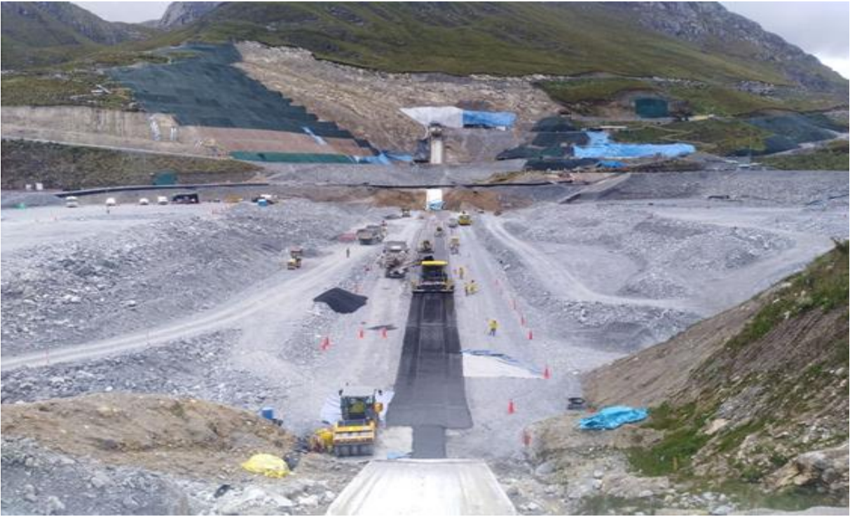
Figura 48: Vista de la capa colocada con concreto asfáltico, fuente elaboración propia.
