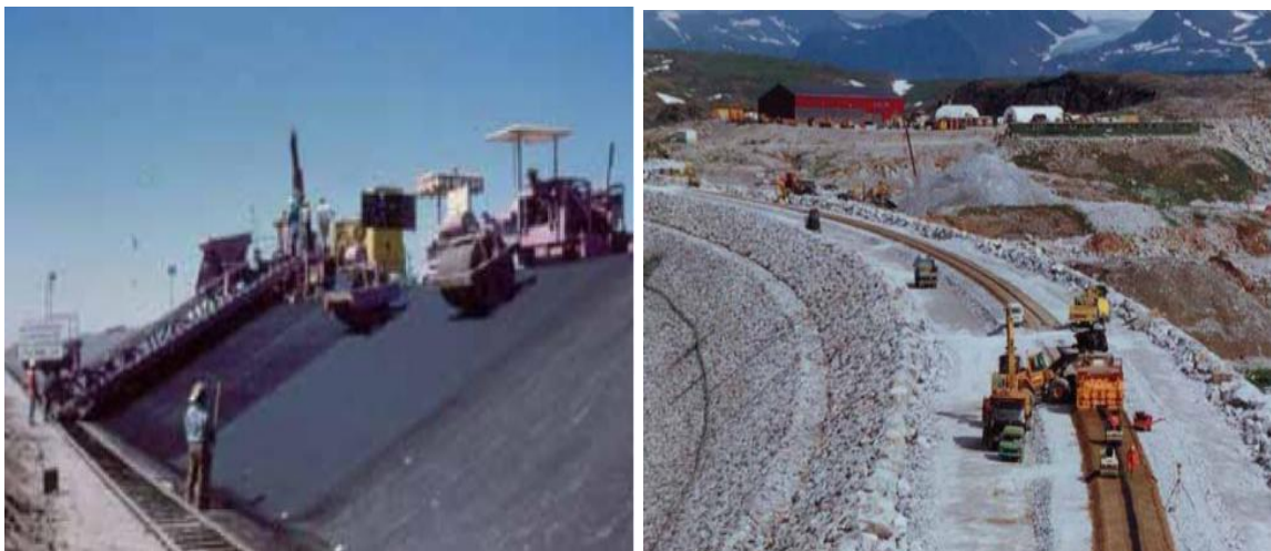
Figura 7: Izquierda: Extendido y compactación de concreto asfáltico en talud de canal (Orozco R., 2008), Derecha: Construcción de presa Storglomvath - Noruega usando núcleo de concreto asfáltico impermeable Hoeg, K. (1993).
