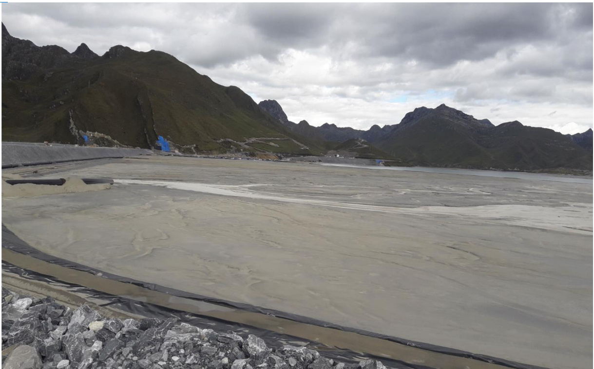
Figura 1: Vista de la presa de relaves tomada desde el estribo izquierdo, fuente elaboración propia.
