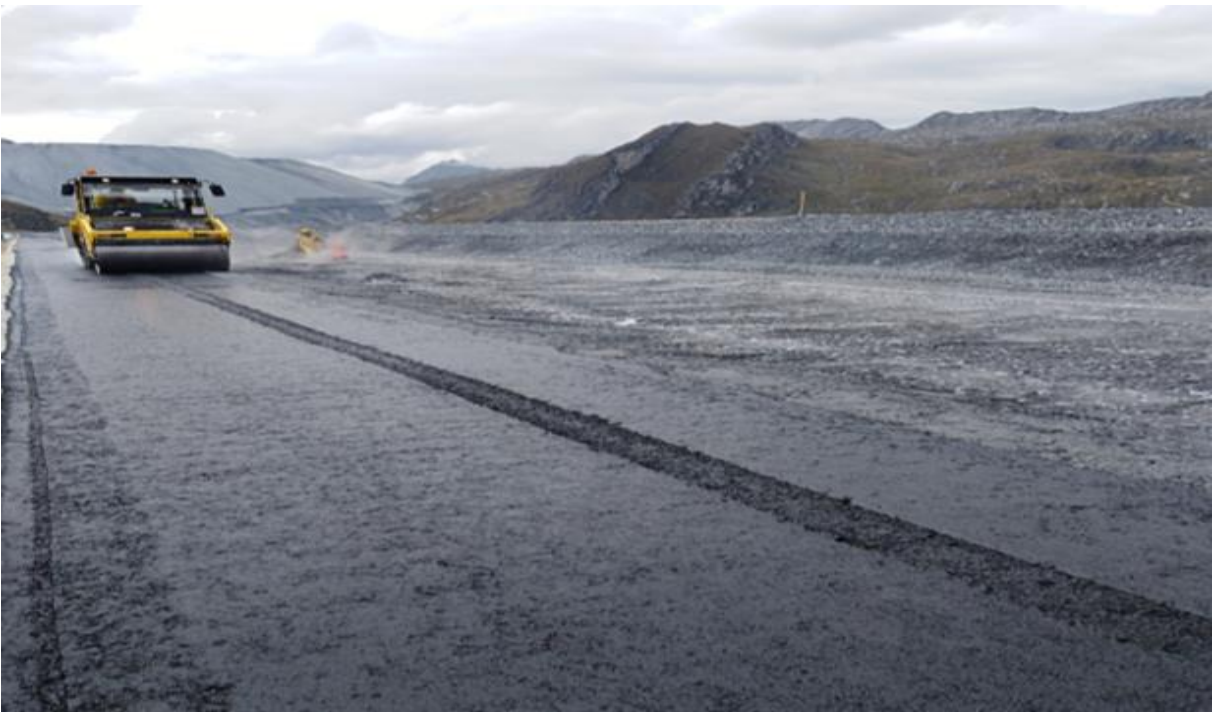
Figura 47: Inicio de planchado con el rodillo tanden a la mezcla asfáltica extendida en la presa de relaves, fuente elaboración propia.
