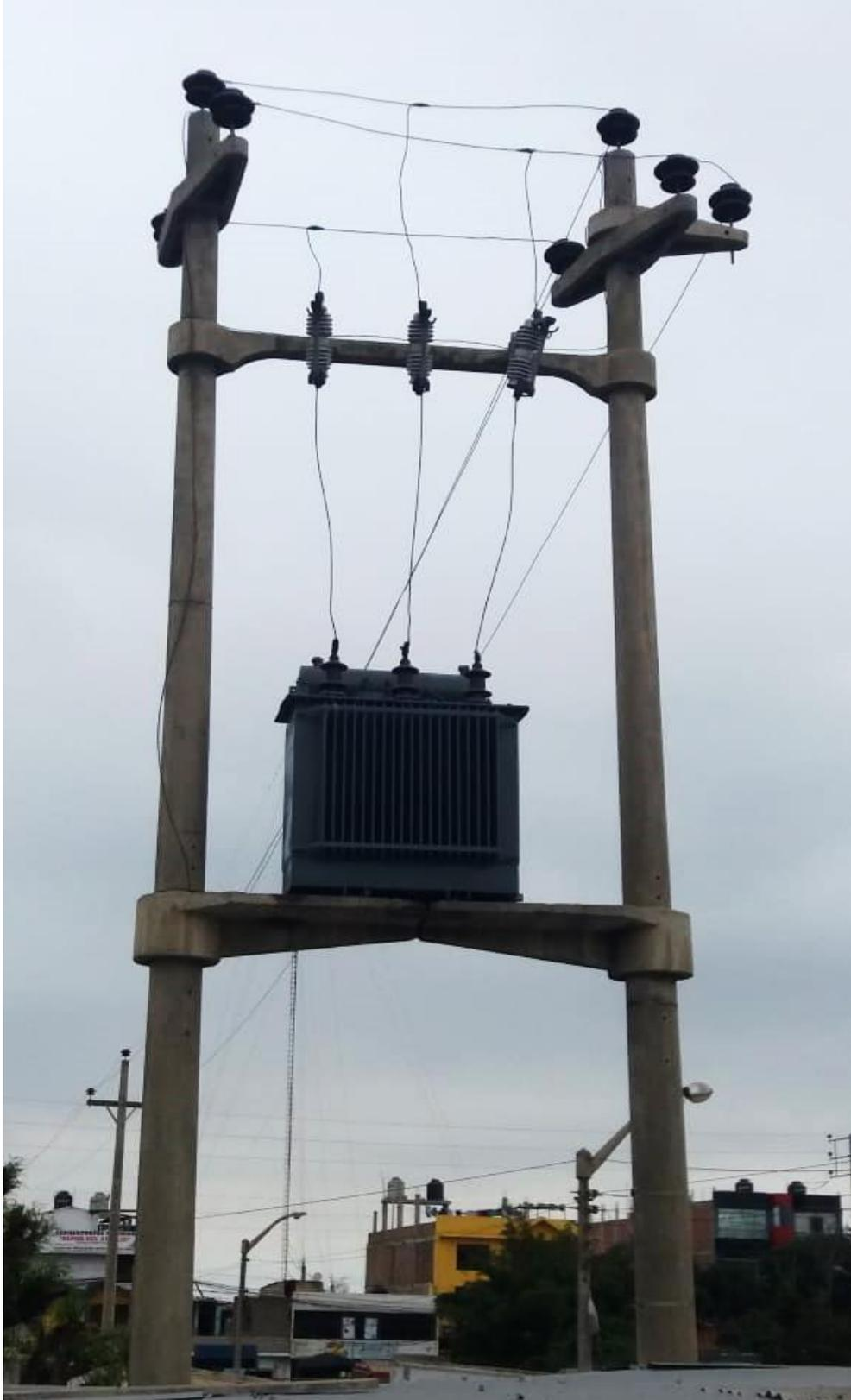
Figura 11: *Transformador tipo poste a la intemperie.*
