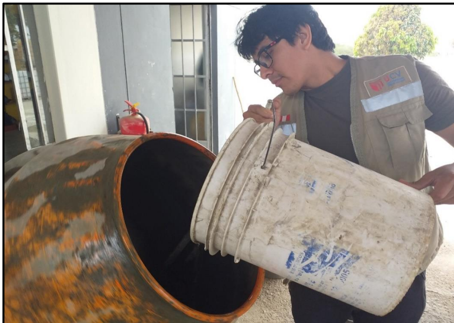
Figura 50. Vertido de materiales, no olvidar iniciar con agua y los agregados.
