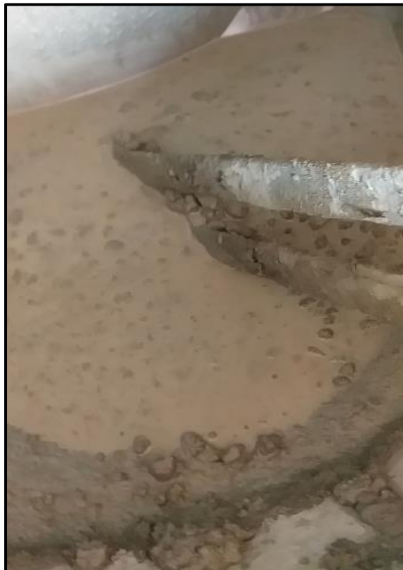
Figura 40. Mezcla con 1.5% de aditivo, presenta segregación.
