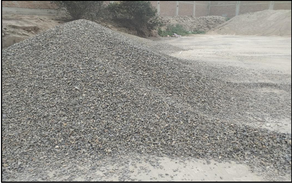
Figura 12. Almacenamiento del agregado grueso.
