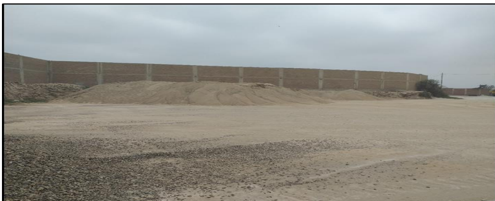
Figura 11. Almacenamiento del agregado fino.
