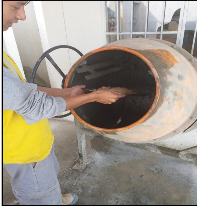
Figura 51. Vertido de materiales, las adiciones pueden mezclarse con el cemento o adicionados como material dosificado.
