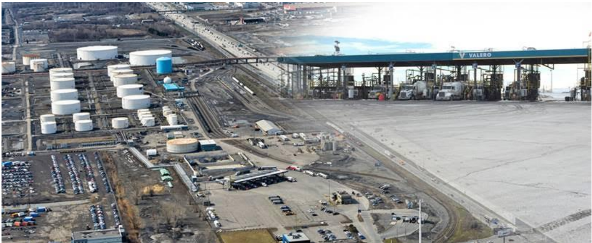
Le plus grand terminal pétrolier au Canada
