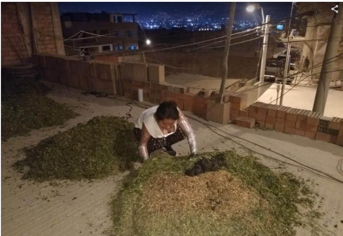
Descripción: mezcla del lodo residual producto del proceso anaerobio con residuos verdes provenientes del cementerio para el proceso de pre-compostaje
