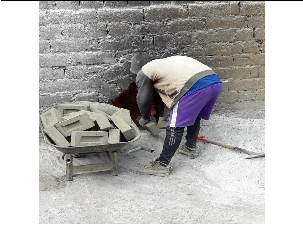
Fotografía 11. Llenado del horno con ladrillos antes de quemarlos
