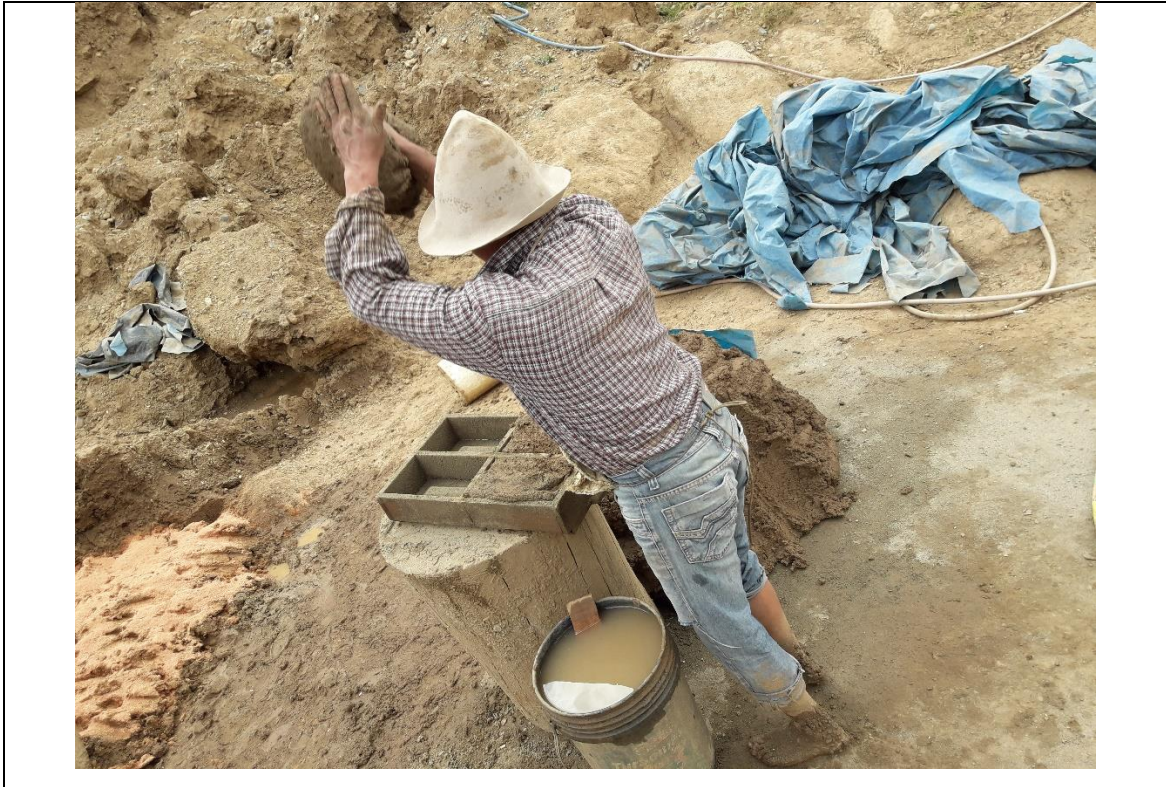
Fotografía 07. Compactación de la masa dentro del molde
