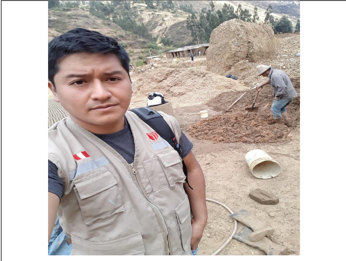
Fotografía 05. Seguimiento del proceso de fabricación de los ladrillos
