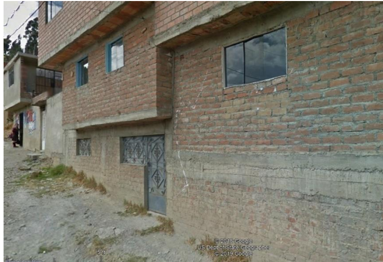
Figura 2. Aplicación del ladrillo fabricado de forma artesanal en las viviendas construidas en Huaraz, fuente (propia del autor)
