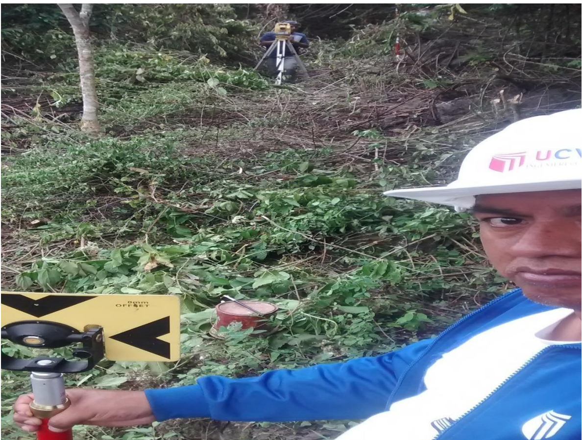
FOTO 10: LLEVANDO A CABO EL LEVANTAMIENTO TOPOGRAFICO
