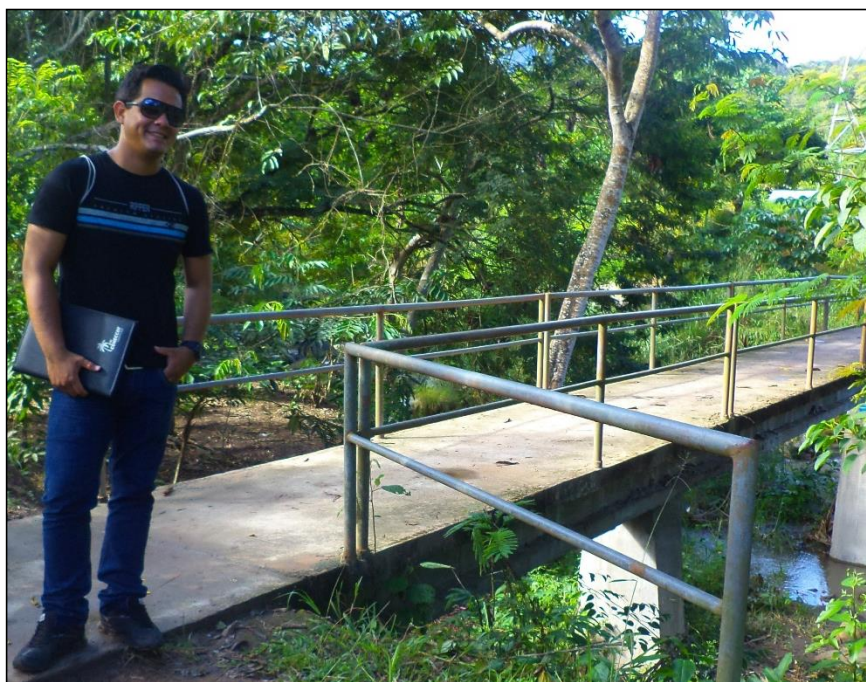
Figura 32: Ingreso por el puente peatonal
