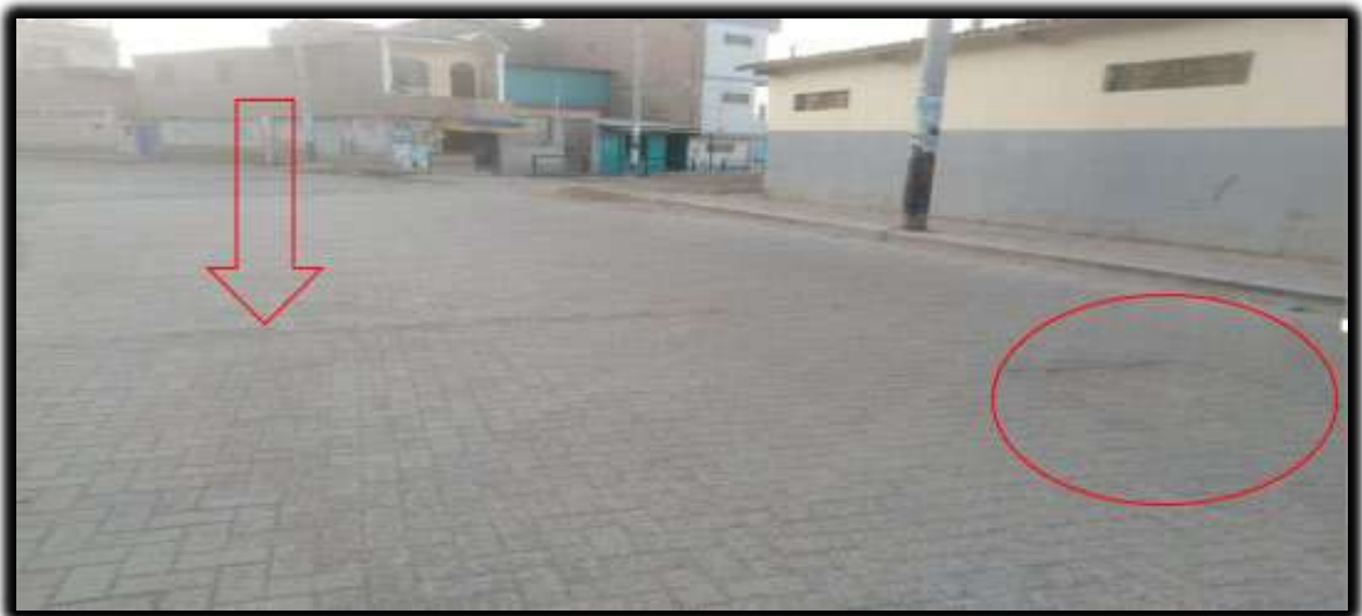
Figura 10. Presencia de baches
