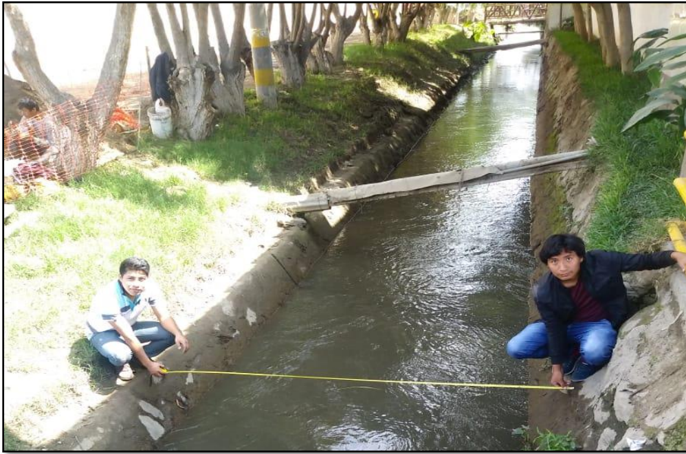
Canal Vichanzao – sección trapezoidal y revestido con concreto y piedra.
