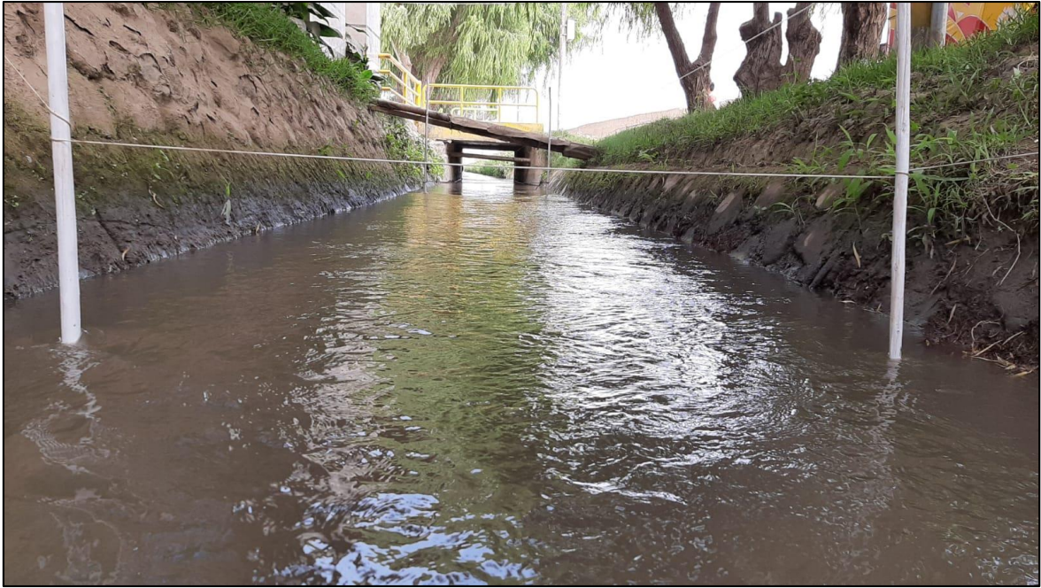
Identificación del tramo a estudiar en el canal Vichanzao
