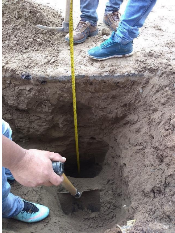
Figura 29: Excavación de la C-1
