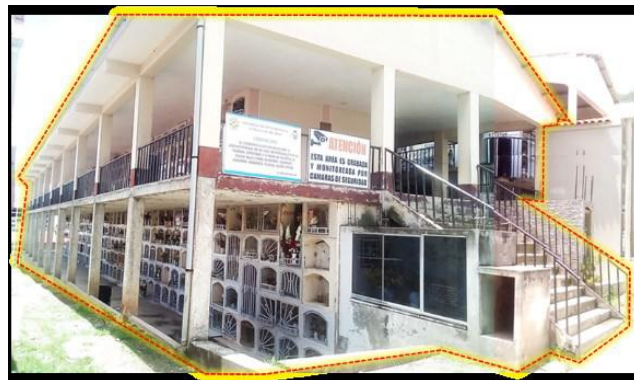
Figura 8: Edificio de nichos de 2 niveles
