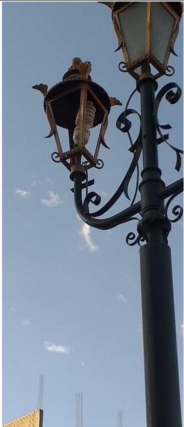
Imagen 79: Faros ubicados en la plaza de armas, sin vidrios en los focos y sin cubierta para estos.
