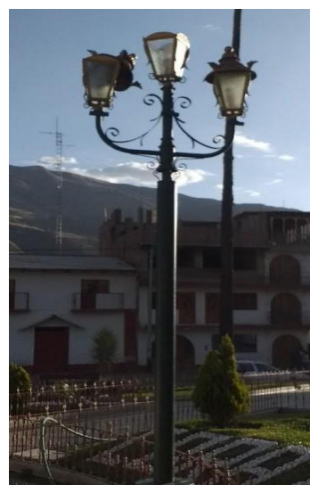
Ilustración 76: Faros ubicados en la plaza de armas, sin vidrios en los focos y sin cubierta para estos.
