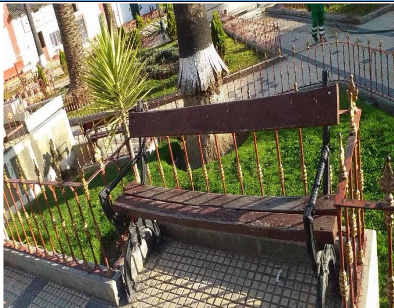
Imagen 75: Banca ubicada en la plaza de armas con los tablonos de madera pandeados.
