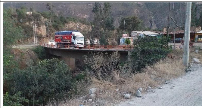
Imagen 96: Fotografía tomada desde el camino para vehículos pesados al Puente Mancos.
