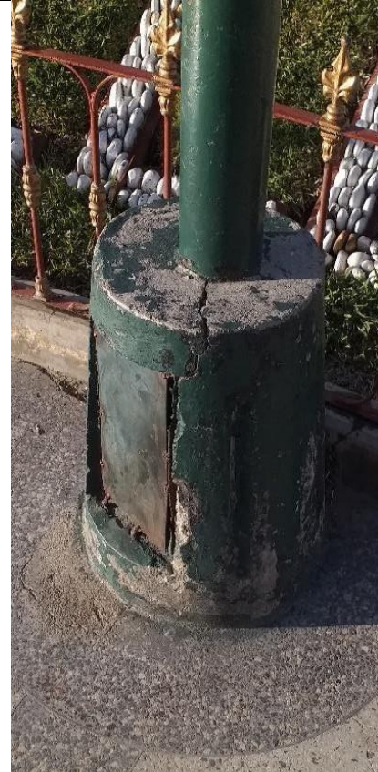
Imagen 80: Base de faro, despintado y con una grieta en su superficie.
