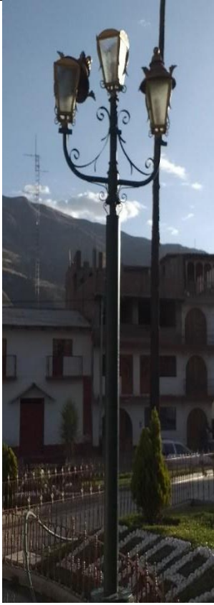
Imagen 79: Faros ubicados en la plaza de armas, sin vidrios en los focos y sin cubierta para estos.
