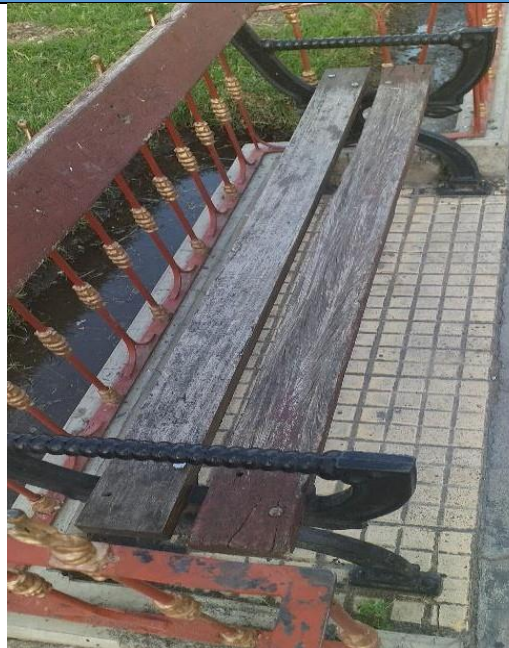
Imagen 76: Banca con tablonos de madera despintados.
