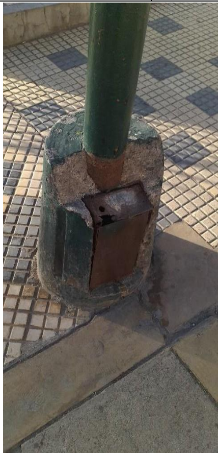
Imagen 82: Parte inferior de faro oxidada, y con desprendimiento de concreto en su base.
