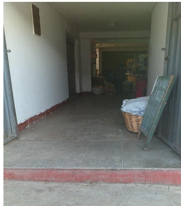
Imagen 100: Ingreso al mercado del distrito de Mancos.
