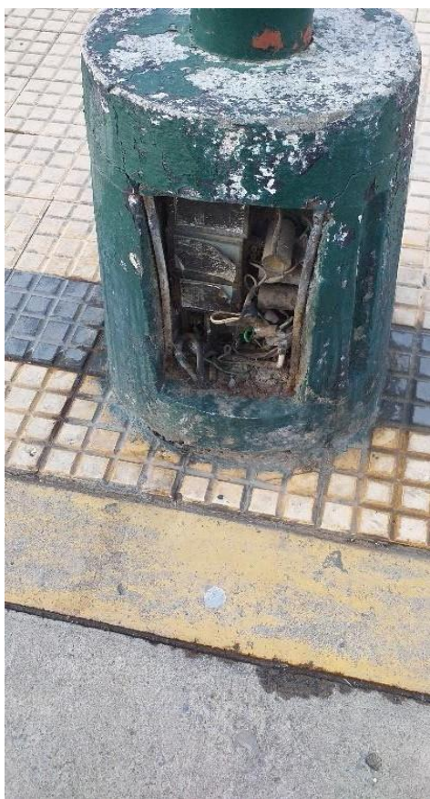
Imagen 81: Cables expuestos en un faro.
