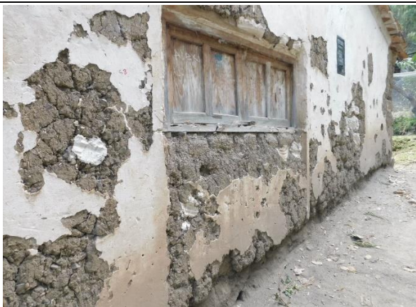
Imagen 20: Vivienda con muros de adobe ubicada en el recorrido del segundo camino propuesto.
