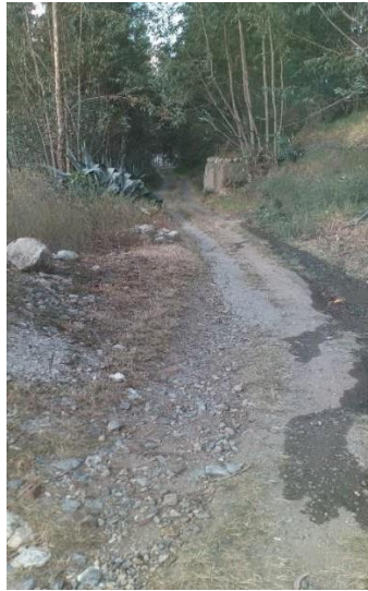
Ilustración 55: Primera ruta que va paralela al río Mancos, sin ningún tipo de mantenimiento.
