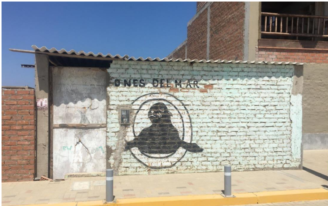
Figura N° 12. Infraestructura de la escuela de surf “Leones del Mar”.
