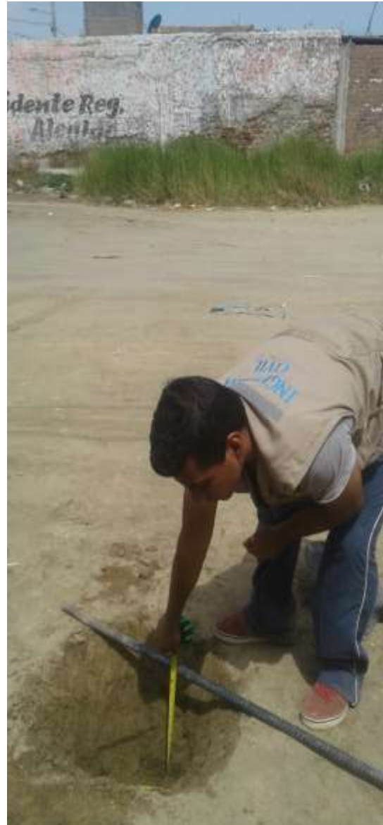
IMAGEN N°8: Tomando la respectiva medida de la profundidad de la calicata, en la que se encontró la napa freática, realizada en el AV. Miraflores
