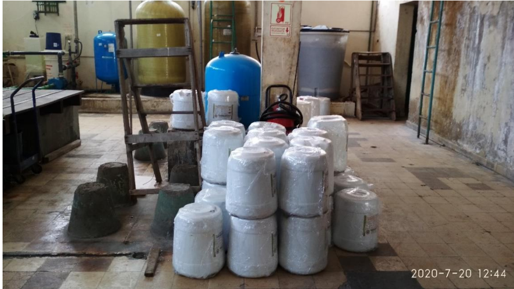
Figura 11: desorden de insumos en área de calderos
