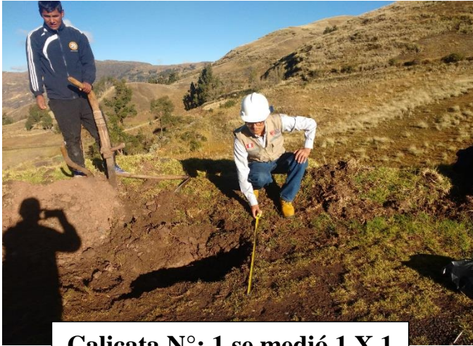
Calicata N°: 1 se medió 1 X 1 X 1.50m
