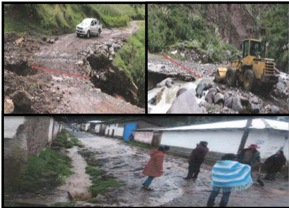
Figura 7: carece de obras de arte
