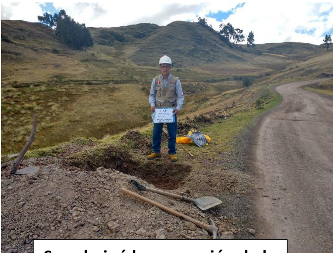
Se culminó la excavación de la calicata
