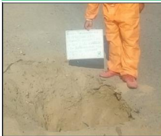
FOTO 05: SE OBSERVA LA EXCAVACIÓN CALICATA C-03.
