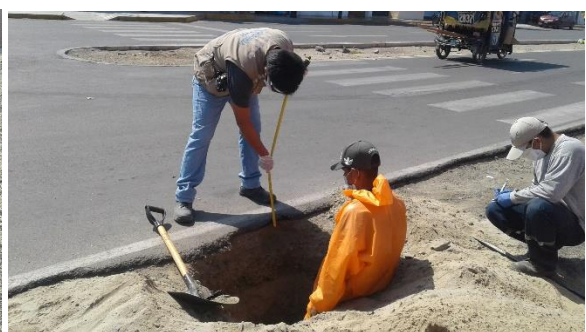
Realización de la calicata N° 4 en la Av. Integración
