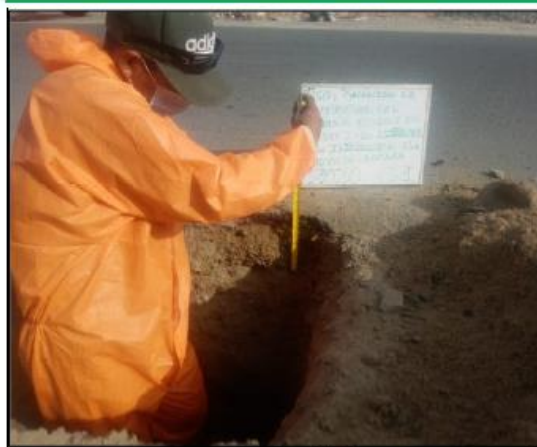
FOTO 01: SE OBSERVA LA EXCAVACIÓN CALICATA C-01.
