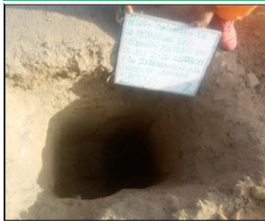
FOTO 03: SE OBSERVA LA EXCAVACION CALICATA C-02.
