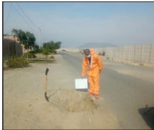
FOTOS 06: SE OBSERVA UNA VISTA PANORÁMICA DE LA EXCAVACION DE LA CALICATA C-03.
