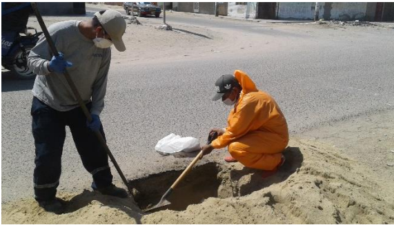
Excavación de la calicata N° 5 en la Av. Integración
