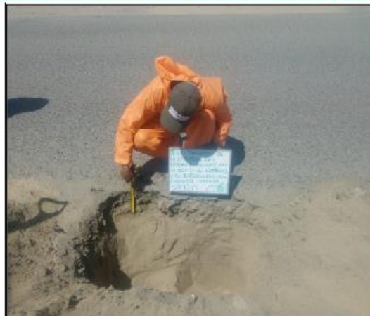
FOTO 11: SE OBSERVA LA EXCAVACIÓN CALICATA C-06.
