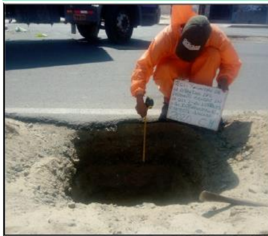
FOTO 07: SE OBSERVA LA EXCAVACIÓN CALICATA C-04.
