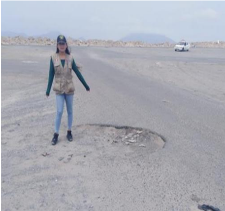
Inspeccionamiento del estado del pavimento flexible de la Av. Alcatrazes.
