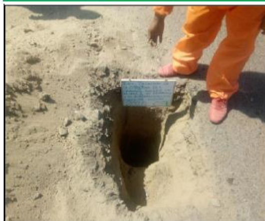
FOTO 13: SE OBSERVA LA EXCAVACIÓN CALICATA C-07.
