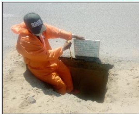
FOTO 09: SE OBSERVA LA EXCAVACIÓN CALICATA C-05.
