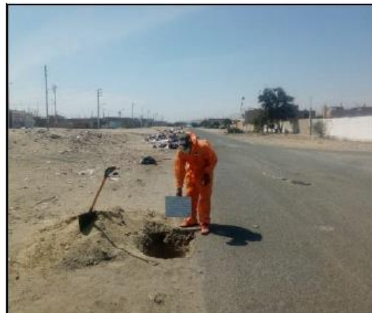
FOTOS 14: SE OBSERVA UNA VISTA PANORÁMICA DE LA EXCAVACION DE LA CALICATA C-07.
