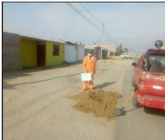
FOTOS 04: SE OBSERVA UNA VISTA PANORAMICA DE LA EXCAVACION DE LA CALICATA C-02.
