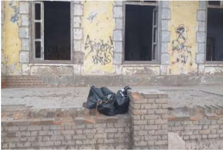
Figura 8: Foto del descuido y contaminación que existe en la Casa Hacienda El Fortin
