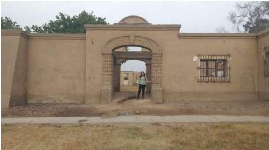
Figura 5: Foto a la entrada de la Casa Hacienda El Fortin
