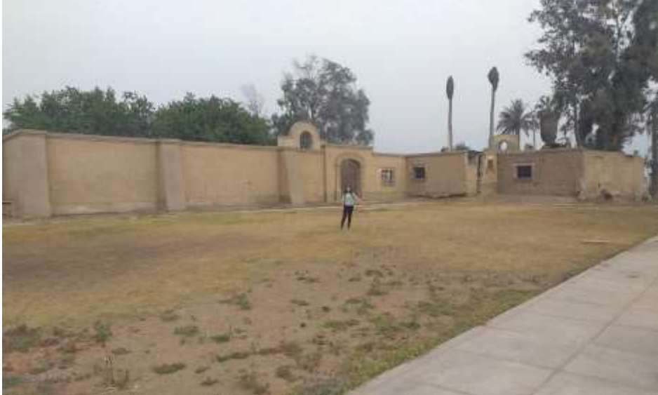
Figura 4: Foto de la Casa Hacienda El Fortin en el distrito de Carabaylo
