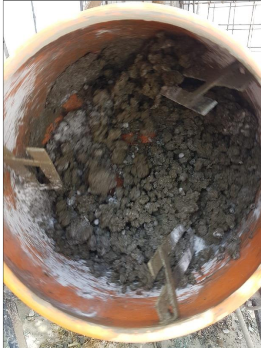
Ilustración 7. Mezclado del concreto
