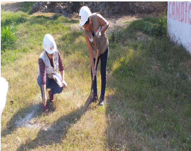
EXTRACCION DE CALICATA
