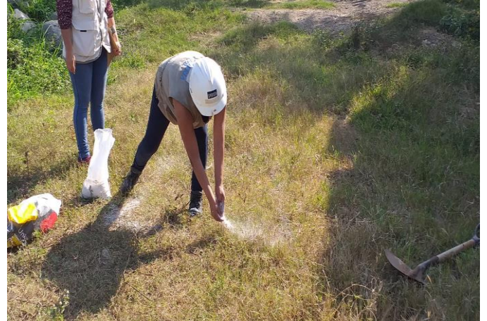
MARCACION PARA LA CALICATA
