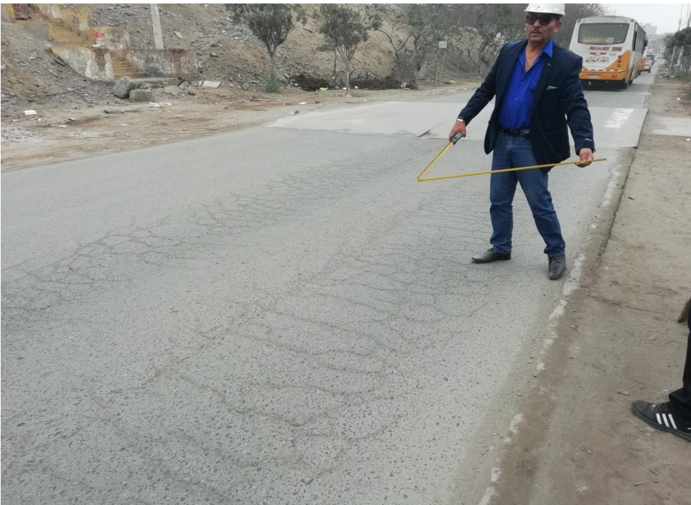
Fotografía 6 M6 Fisuras de piel de cocodrilo y ahuellamientos.
