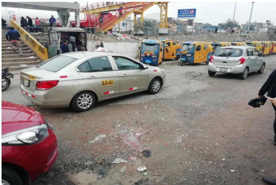
Fotografía 2. Progresiva 0+000 (Puente peatonal Amauta) ojo de pescado
