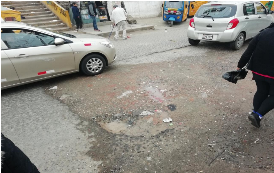
Progresiva 0+000 (Puente peatonal Amauta) ojo de pescado
