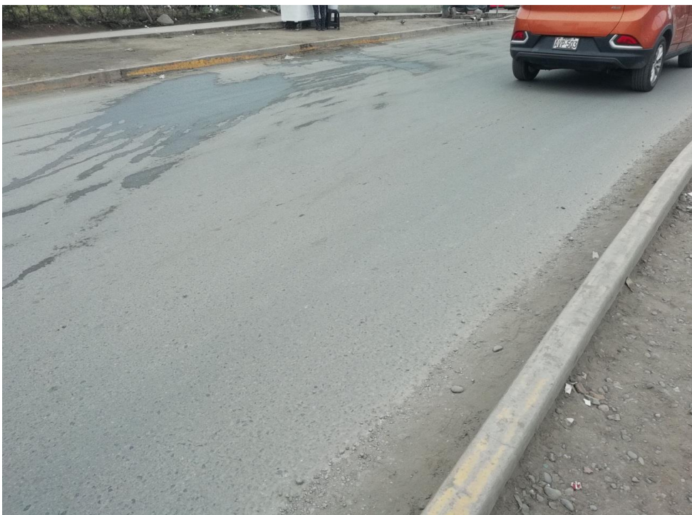
Fotografía 19 M19 Sin fisuración, Sin deformación.
