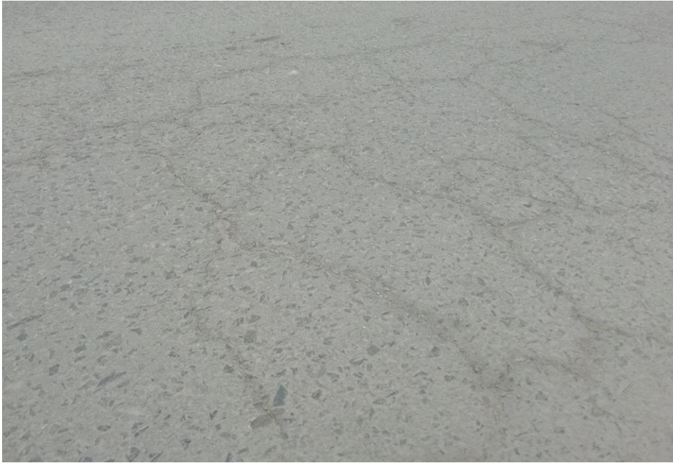
Fotografía 6 M6 Fisuras de piel de cocodrilo y ahuellamientos.
