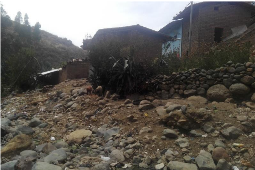
Figura 22. Vivienda construida en el margen derecho del río del tramo 3.
