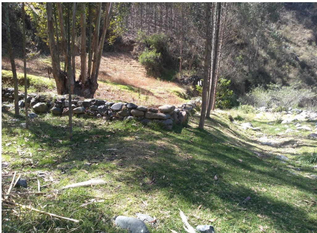
Figura 17. Punto crítico del primer tramo.
