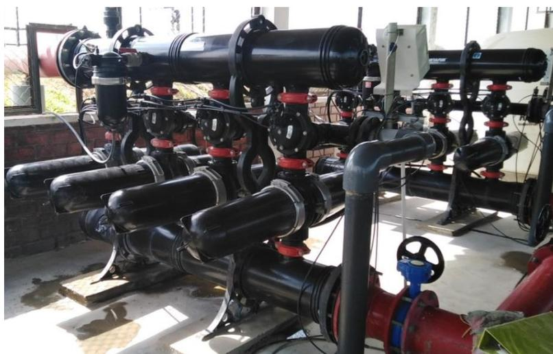
*Figura 7:* Batería de filtrado Apollo Angle
