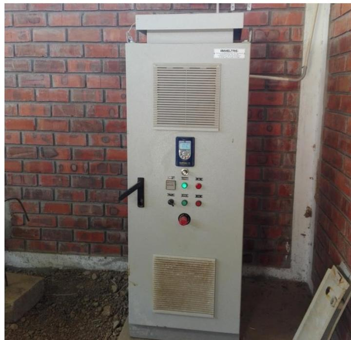
*Figura 9:* Tablero eléctrico de 50 HP
