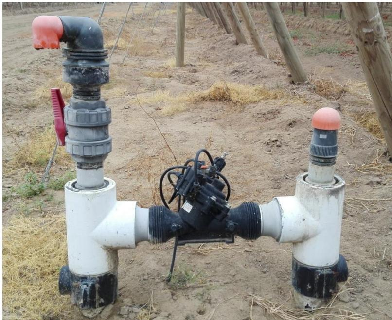
*Figura 10: Válvulas hidráulicas reductoras*
