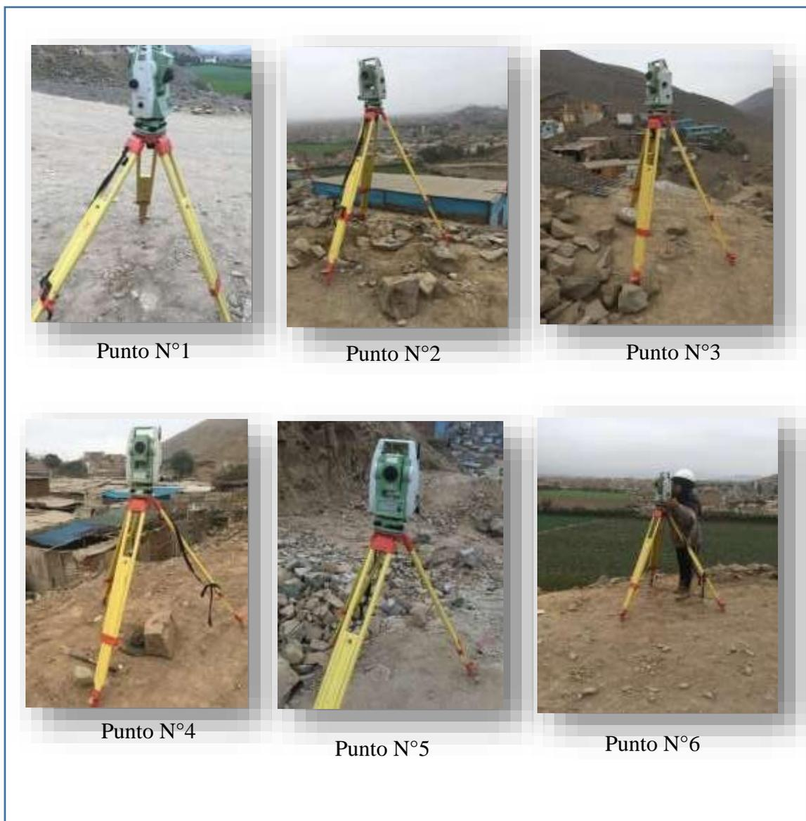
*Figura 16: Vértices de la poligonal con estación total*
