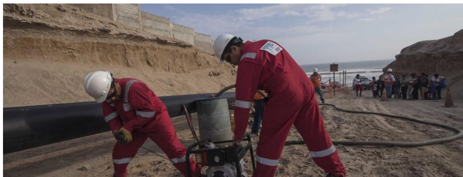
Figura 16: Verificación de líneas de recepción de Buque Tanque hacia la Planta Eten
