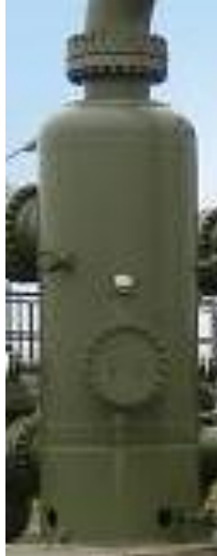
Figura 22:Depurador de succión
