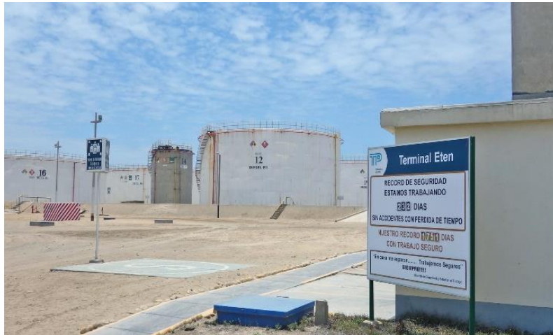
Figura 1: Tanques de almacenamiento de Terminal Eten
