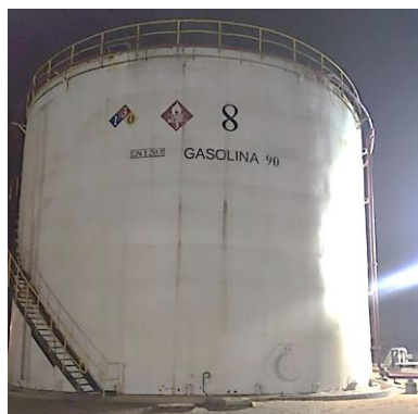
Figura 12: Tanque de gasolina 90 Octanos en planta Eten
