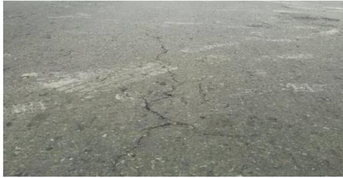
Figura 61. Grieta Longitudinal – km 2+750 – Calzada Creciente – Carril Externo.
