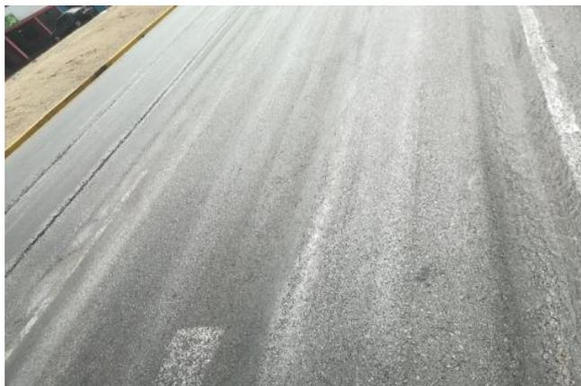
*Figura 21. Ahuellamiento – km 0+200 –. Calzada Creciente – Carril Externo.*
