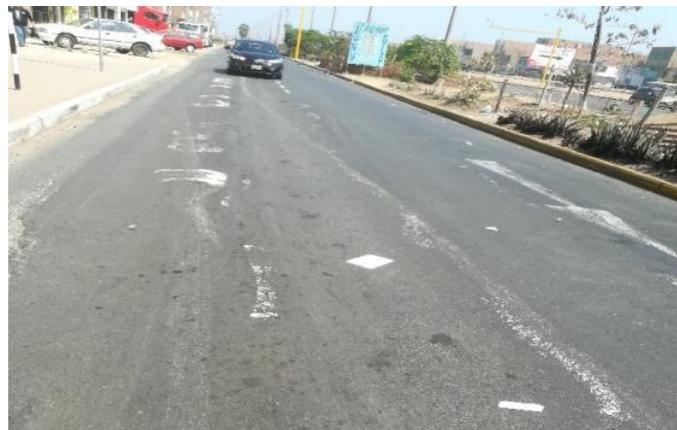
*Figura 78. Ahuellamiento – km 3+425 – Calzada Creciente – Carril Externo.*
