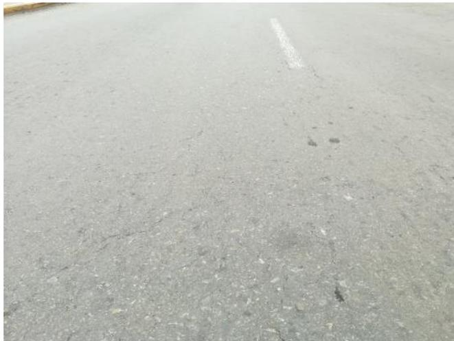
*Figura 70. Grietas Transversales y Longitudinales – km 3+280 – Calzada Creciente – Carril Externo.*
