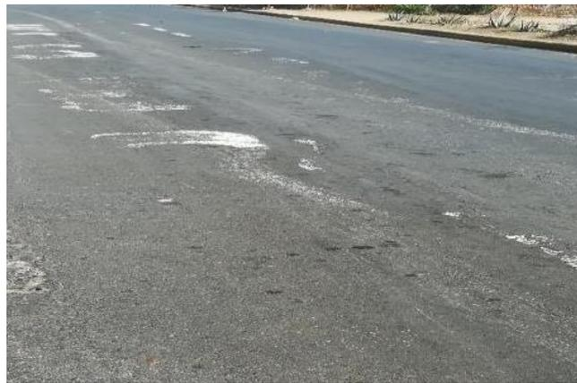
Figura 46. Ahuellamiento – km 1+525 – Calzada Creciente – Carril Externo.
