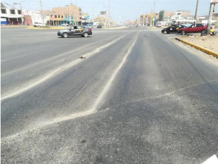
*Figura 13.* Ejemplo del tipo de Falla Grieta Longitudinal y Transversal en el pavimento flexible de la Avenida Canta Callao – Segundo Tramo – km 2+010 – Carril Interno.
