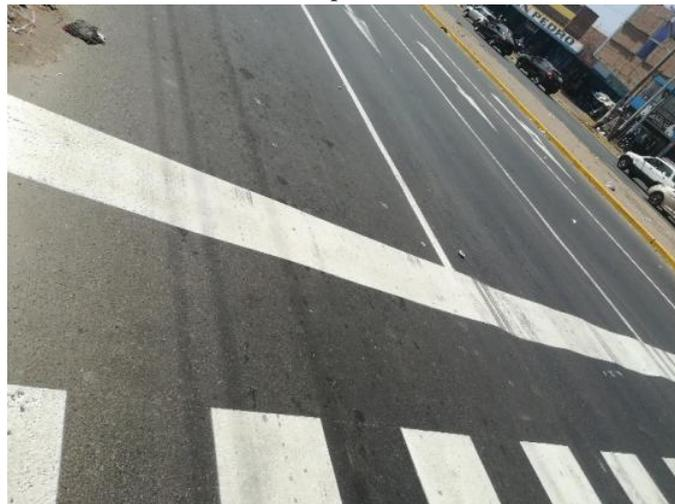
*Figura 54. Ahuellamiento – km 2+720 – Calzada Creciente – Carril Externo.*
