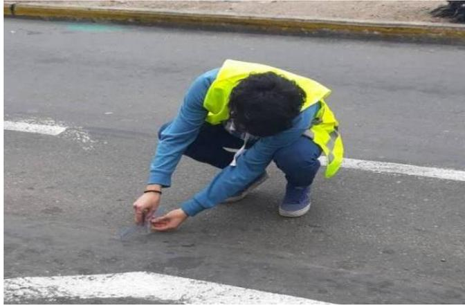
*Figura 64. Medición de la Profundidad del Ahuellamiento – km 2+325 – Calzada Decreciente – Carril Interno.*
