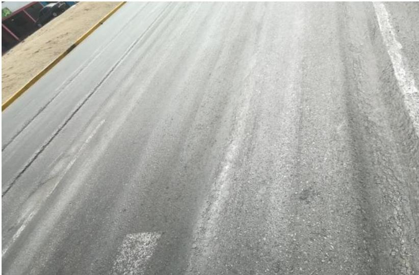
*Figura 15.* Ejemplo del Tipo de Falla Ahuellamiento en el pavimento flexible de la Avenida Canta Callao – Primer Tramo – km 1+030 – Carril Externo.
