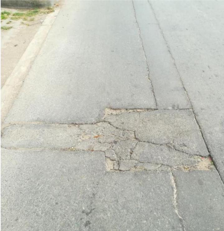
Figura 3. Parche desprendiéndose en el pavimento flexible de la Avenida Canta Callao – Tercer Tramo – km 3+010 – Carril Interno.
