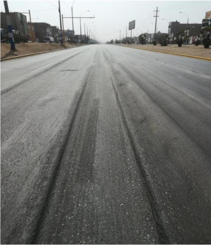
*Figura 1.* Ahuellamiento en el pavimento flexible de la Avenida Canta Callao – Segundo Tramo – km 2+120 – Carril Interno.
