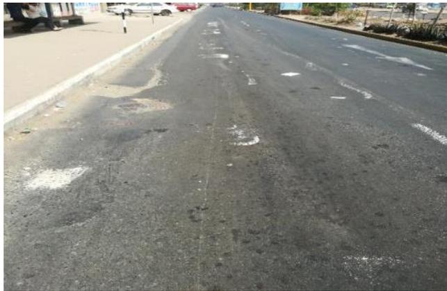
*Figura 27. Ahuellamiento – km 0+325 – Calzada Creciente – Carril Interno.*
