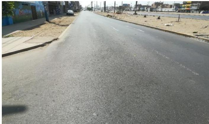
*Figura 75. Ahuellamiento – km 3+325 – Calzada Creciente – Carril Interno.*
