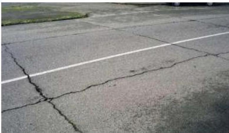
*Figura 14.* Ejemplo del Tipo de Falla Grieta por Reflexión.
