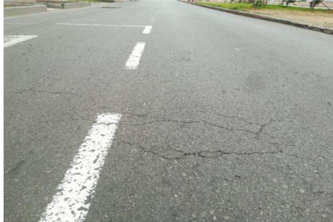
*Figura 29. Grietas Transversales– km 0+525 – Calzada Creciente – Carril Externo.*
