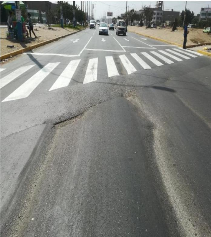
*Figura 2.* Parche en el pavimento flexible de la Avenida Canta Callao – Segundo Tramo – km 2+730 – Carril Interno.
