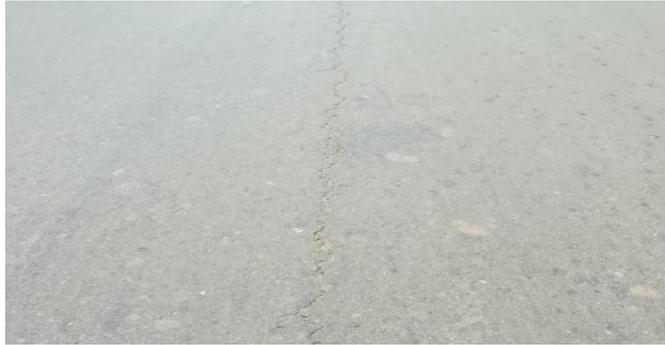
*Figura 36. Grieta Longitudinal– km 1+150 – Calzada Creciente – Carril Interno.*
