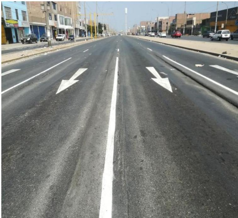
*Figura 67. Ahuellamiento – km 3+040 – Calzada Creciente – Carril Interno.*
