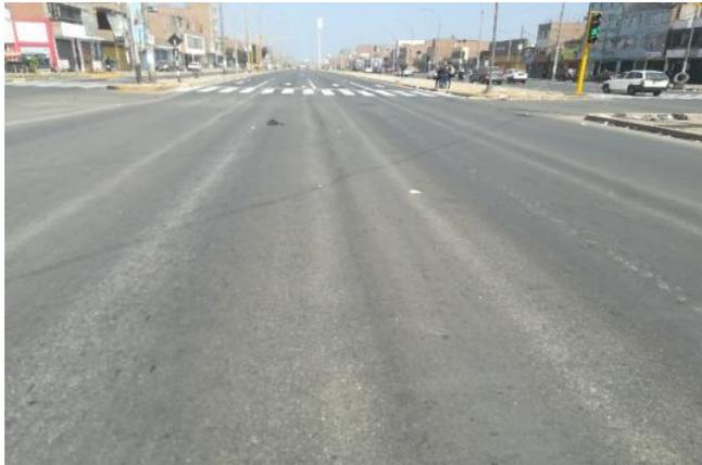
*Figura 69. Ahuellamiento – km 3+220 –. Calzada Creciente – Carril Externo.*
