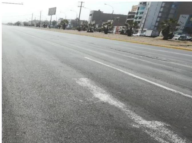
*Figura 22. Ahuellamiento – km 0+280 –. Calzada Creciente – Carril Externo.*
