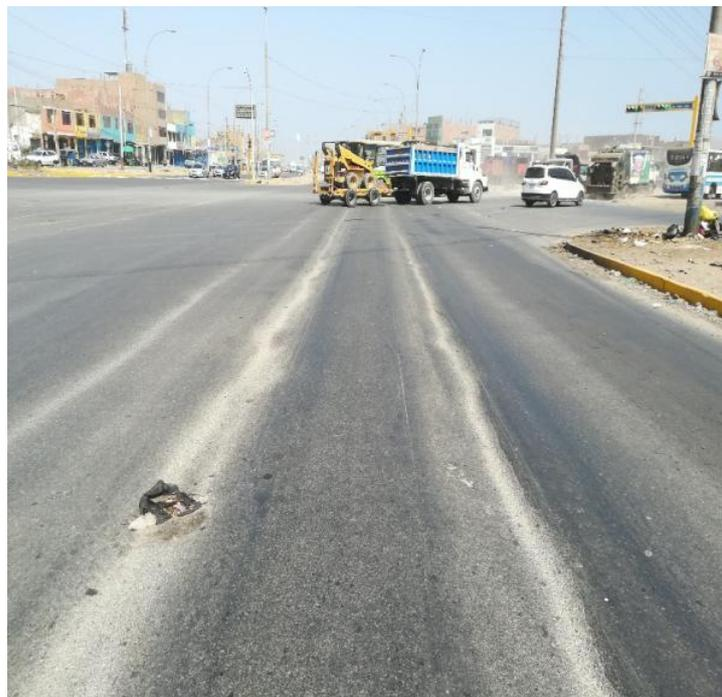
*Figura 35. Ahuellamiento – km 1+140 – Calzada Creciente – Carril Interno.*
