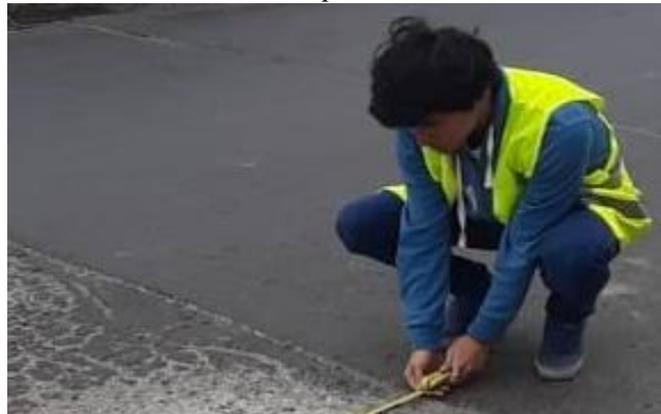
*Figura 60. Medición del área del Parche – km 2+325 – Calzada Creciente – Carril Interno.*
