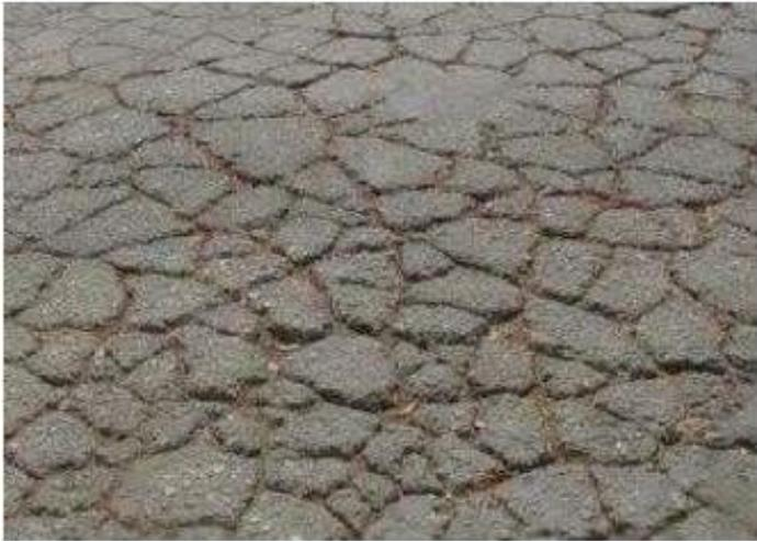
Figura 12. Ejemplo del Tipo de Falla Piel de Cocodrilo.
