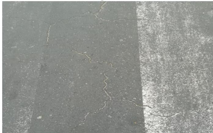
Figura 56. Grietas Transversales y Longitudinales – km 2+320 – Calzada Decreciente – Carril Interno.
