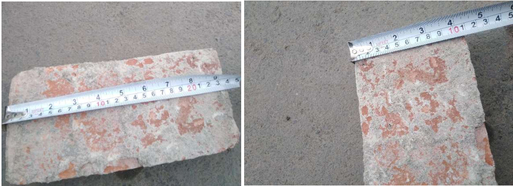
Figura 21. Unidades de Albañilería Usadas en la Edificación.
