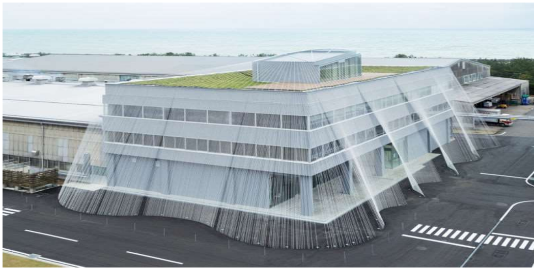
Figura 1. Edificio Reforzado con Fibras de Cabkoma
