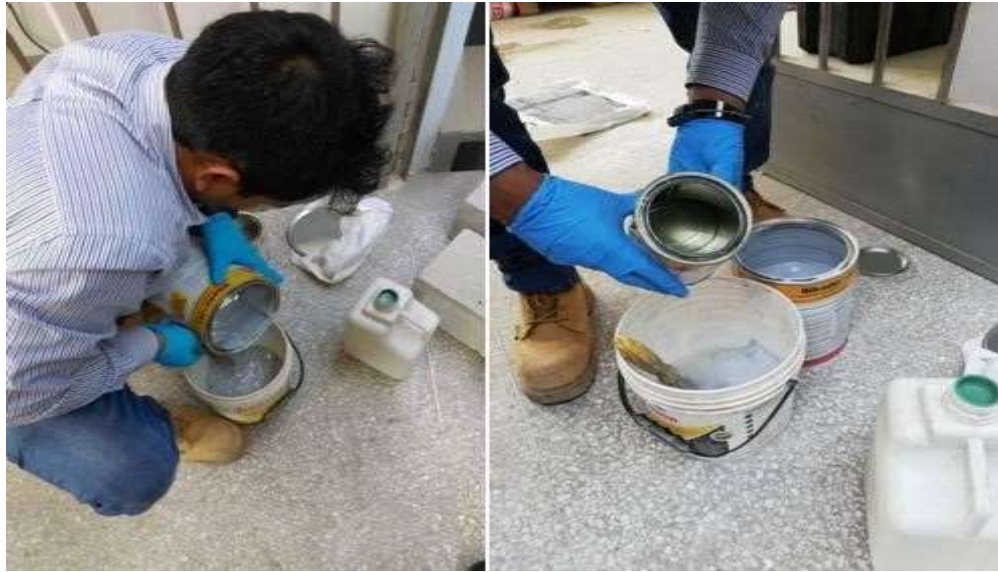
Figura 27. Sikadur 301 Proceso de Mezcla de los Componentes A y B.
