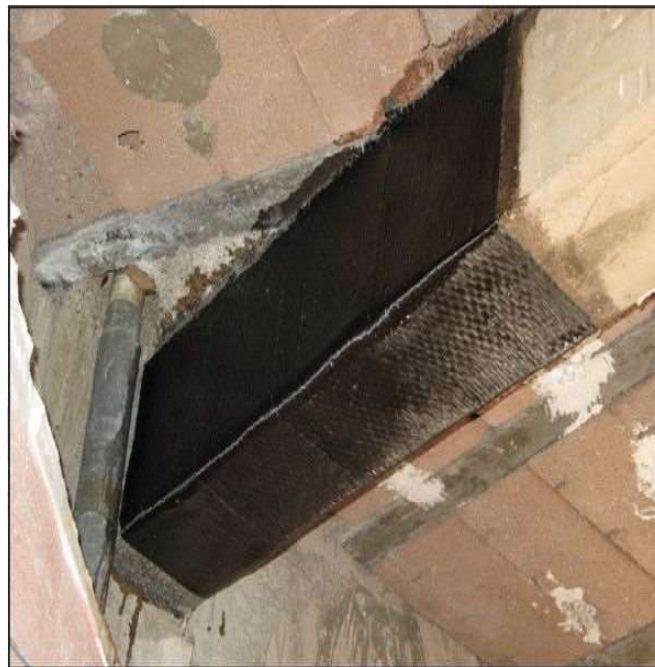
Figura 3. Columna Reforzada con Fibra de Carbono.
