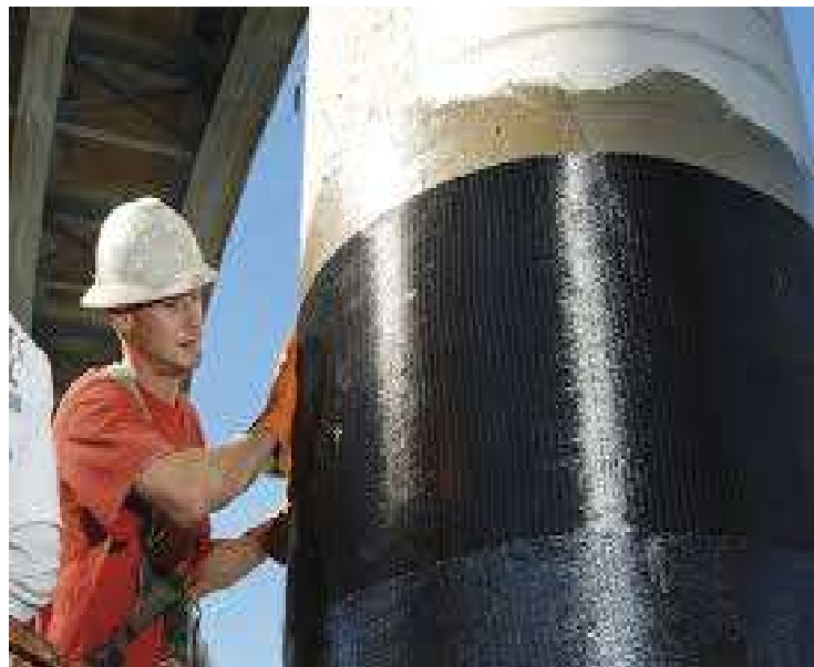
Figura 7. Adhesión de Fibra de Carbono con el Concreto.
