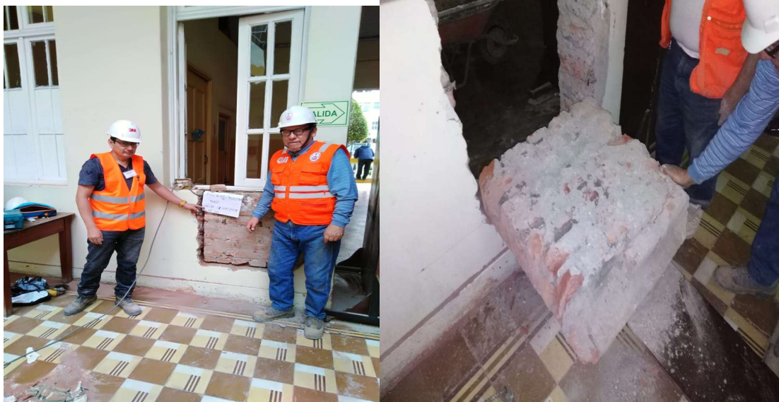
Figura 22. Extracción de muestra de Muro.
