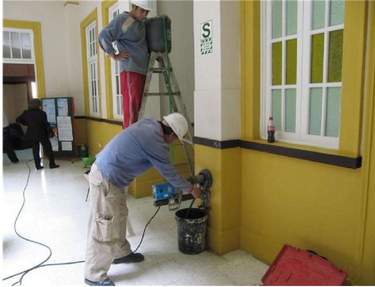
Figura 17. Extracción de Núcleo de Concreto.
