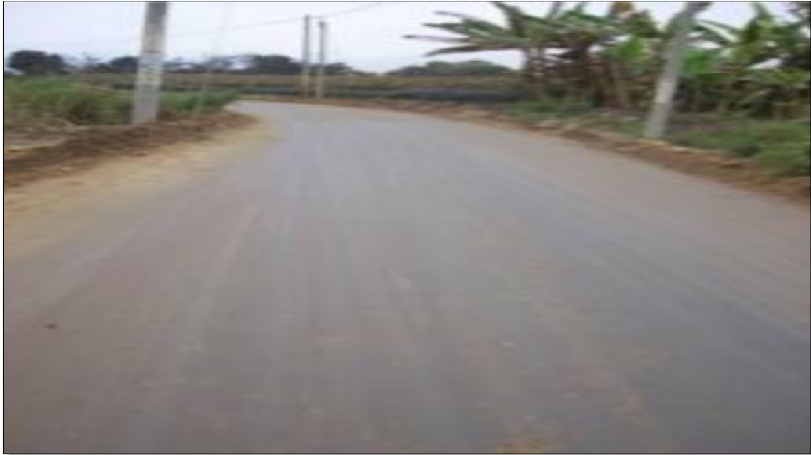
Figura 6. Condición final de la vía.
