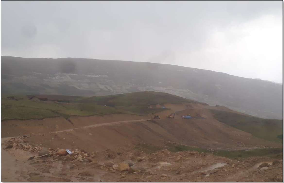
Figura 34. Se muestra tramo más vulnerable de la carretera.
