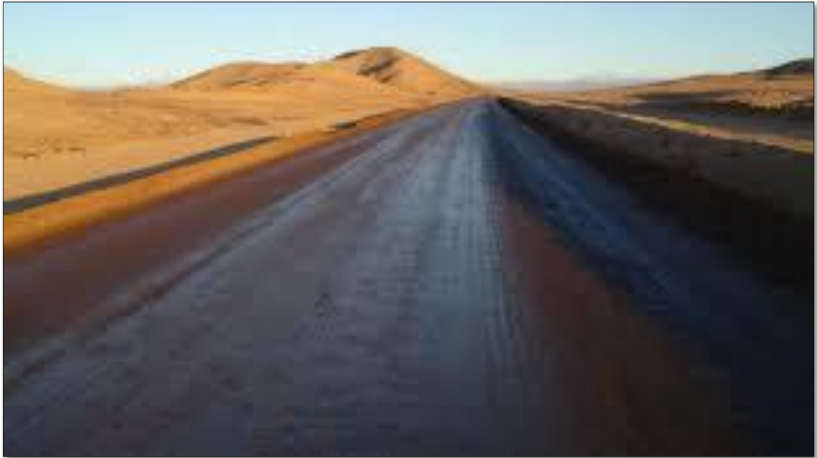
Figura 3. Se muestra carretera no pavimentada con bischofita.
