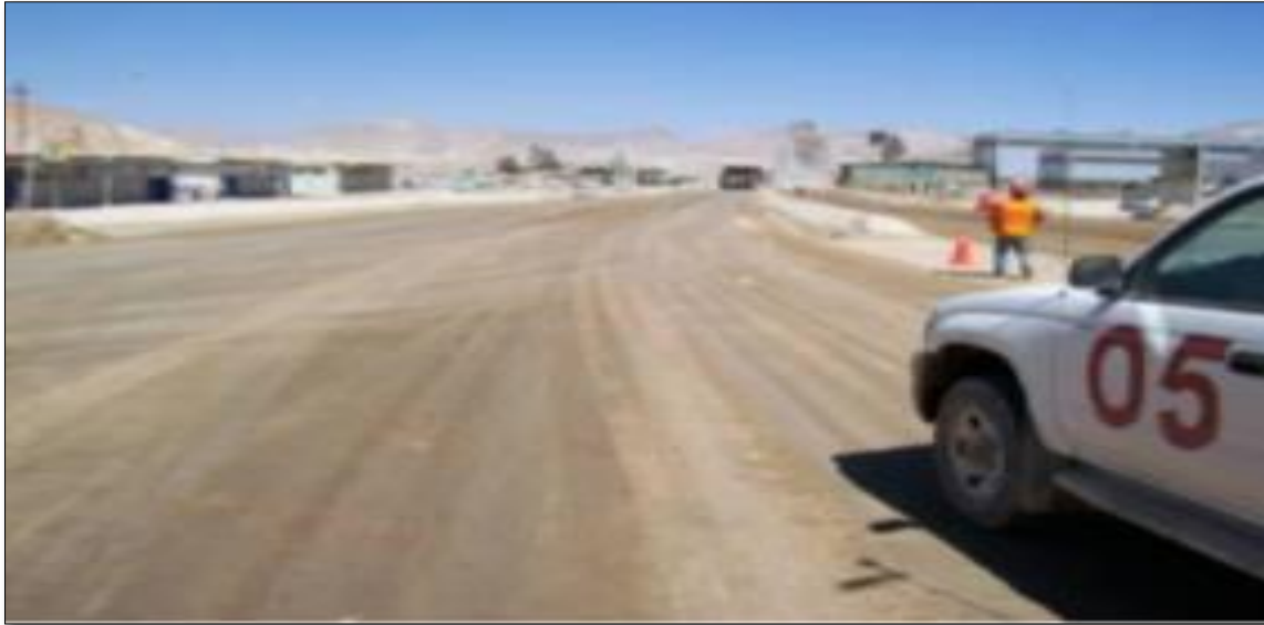
Figura 4. Tramo con la aplicación de bischofita (El después).
