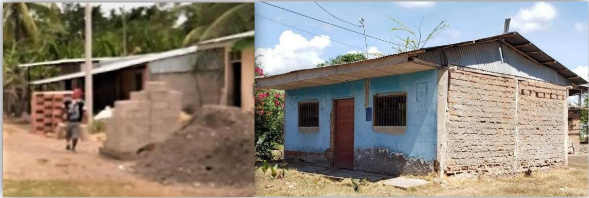
Figura 14. Materiales, mano de obra y estado de estructural.
