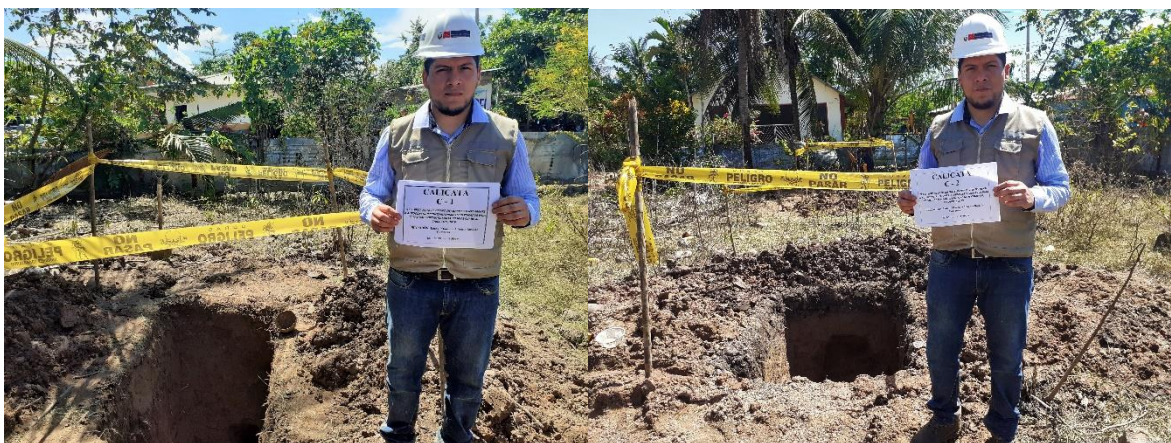
Figura 19. Realización de calicatas Fuente: Propia
