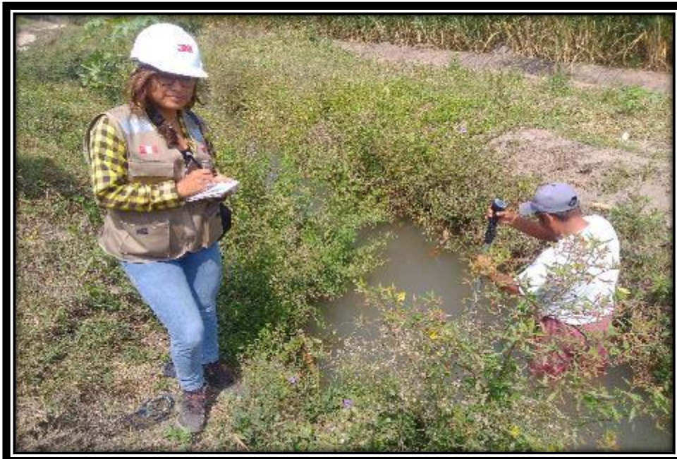
FOTO 04: realizando el aforo en el canal García, con equipo correntómetro.
