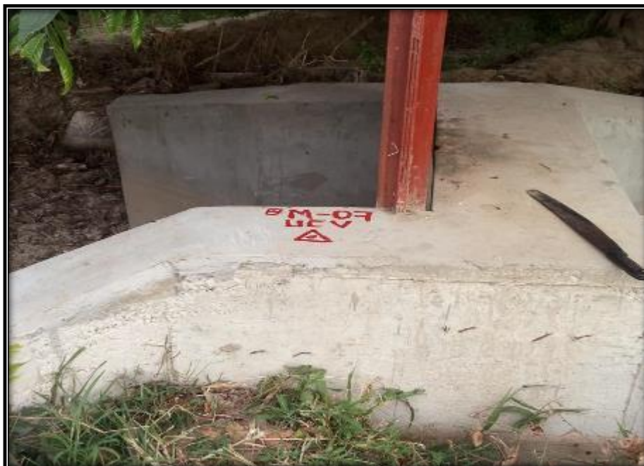
FOTO 06: Se observa BM07, localizado en Muro de concreto de Compuerta
