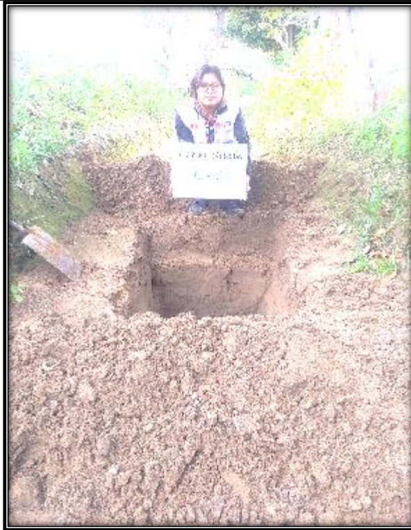
FOTO 02: Excavación y extracción de muestras en la calicata N°02.
