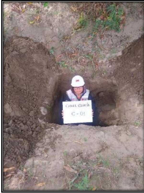
FOTO 01: Excavación y extracción de muestras en la calicata N°01.
