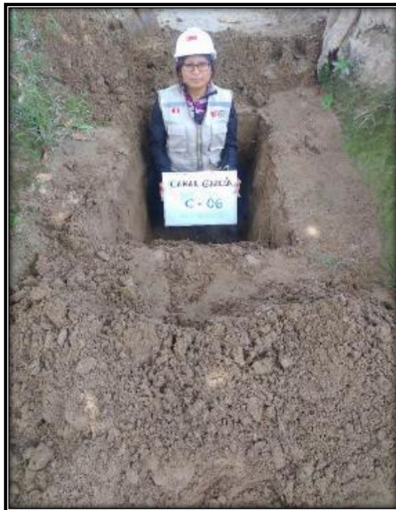
FOTO 06: Excavación y extracción de muestras en la calicata N° 06.
