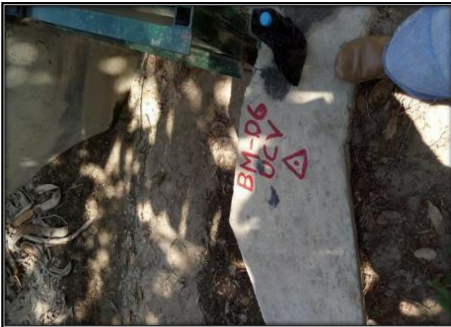
FOTO 05: Se observa BM6, localizado en Muro de concreto de Compuerta
