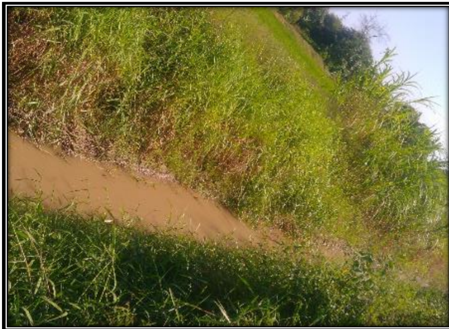
FOTO 02: Canal García tramo no revestido
