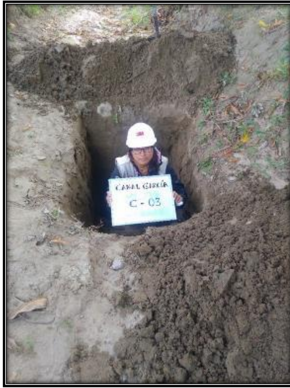
FOTO 03: Excavación y extracción de muestras en la calicata N° 03.
