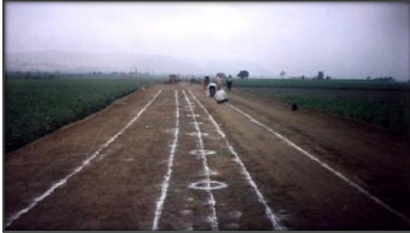
Figura 4. Procedimiento de trazado del eje de un canal Fuente: Recuperado de civilgeeks (2010)
