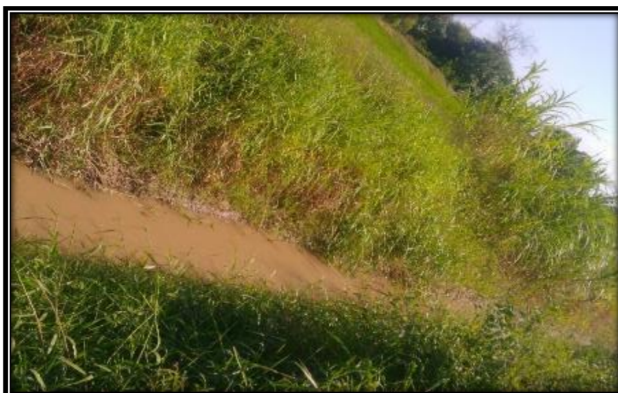
TRAMO DE TIERRA DEL CANAL GARCÍA
