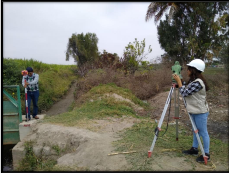
FOTO 01: Inicio del levantamiento topográfico Canal García
