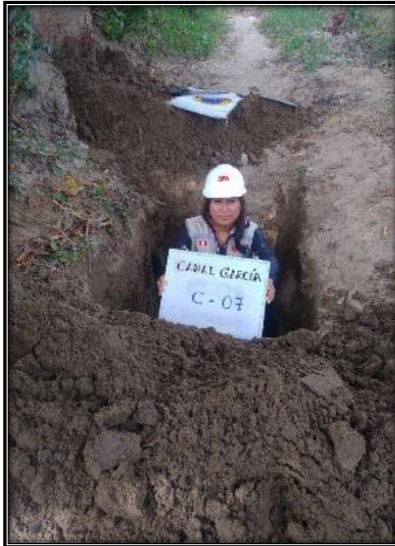
FOTO 07: Excavación y extracción de muestras en la calicata N° 07.
