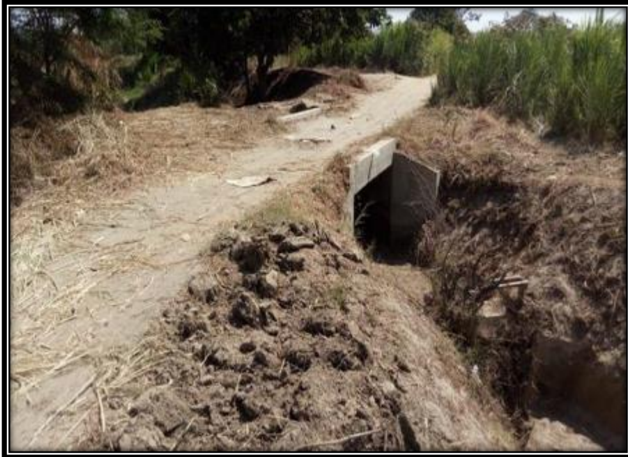
FOTO 06: Alcantarilla tipo cajón existente en el trayecto del canal
