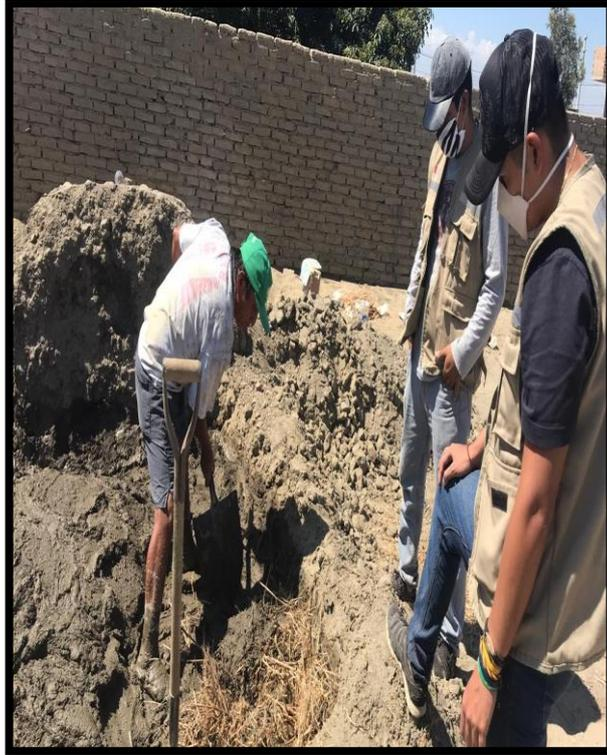
Fotografía: adición de fibra de bambú a la mezcla
