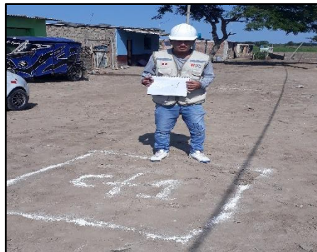
Figura N° 11: Ubicación de la primera calicata
