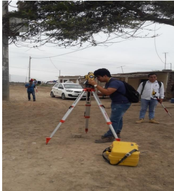
Figura N° 05: Ubicación de la estación del nivel en el centro del terreno.
