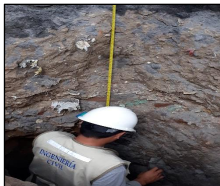
Figura N° 12: Profundidad de calicata 2.50 m.
