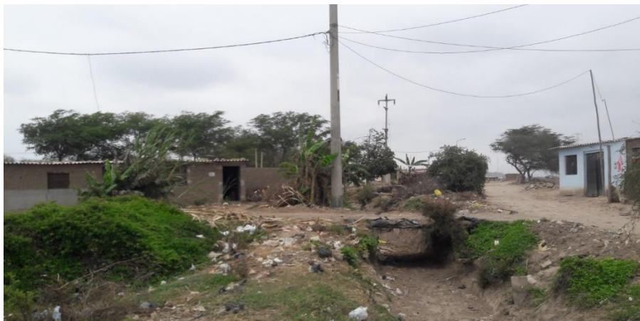
Figura N° 09: Vista del puente en el canal.
