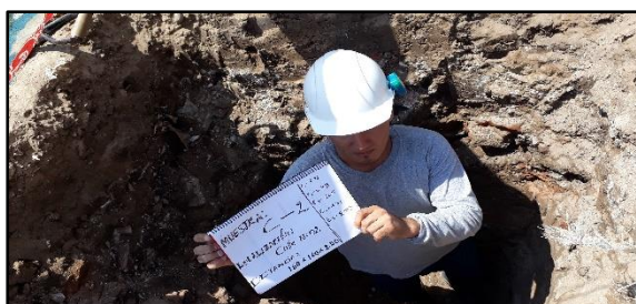
Figura N° 13: Segunda calicata, profundidad 2.50
