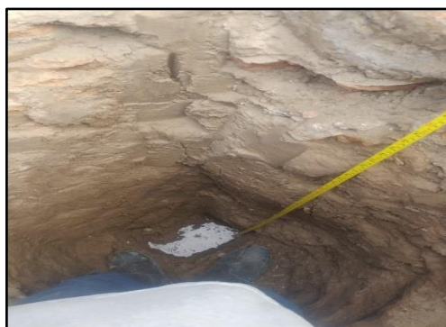
Figura N° 14: A una profundidad de 1.80 m se encontró la Napa freática.
