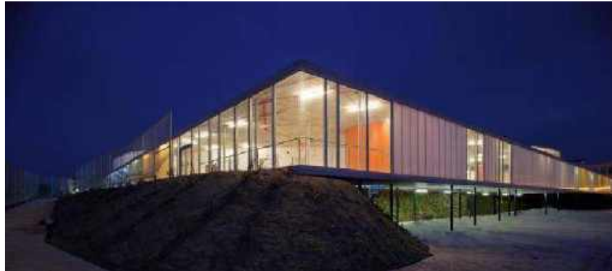
Figura 21. Fachada norte del centro Santa Rita
