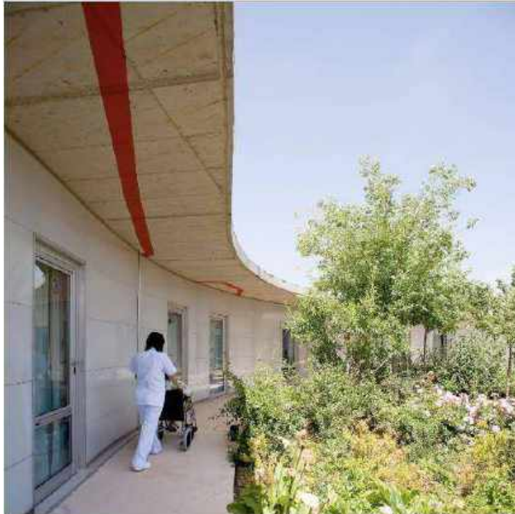
Figura 20. Techo y jardín del centro Santa Rita
