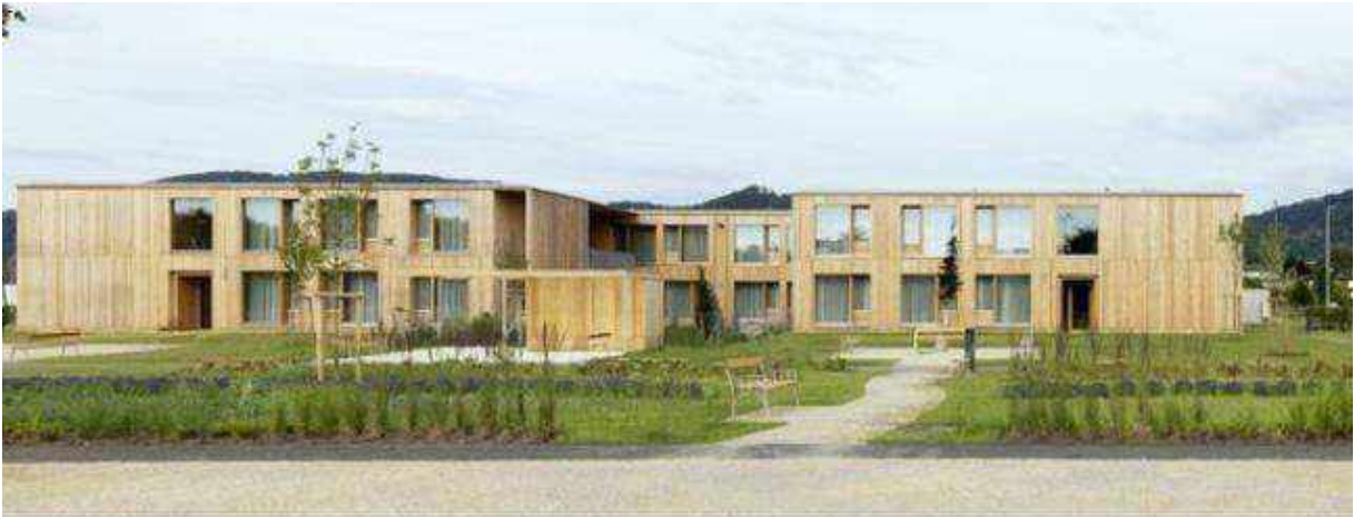
Figura 36. Vista de la casa de reposo Peter Rosegger
