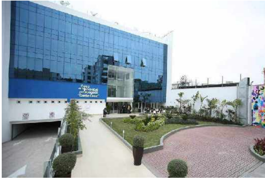
Figura 4. Vista frontal de la Casa de la Juventud Prolongada de Santa Cruz en Miraflores
