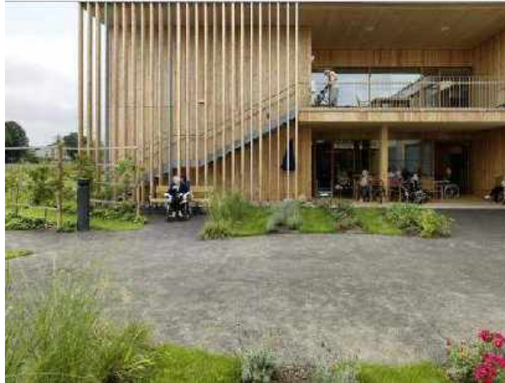
Figura 40. Espacio público de la casa de reposo Peter Rosegger
