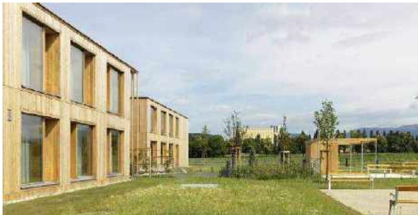
Figura 41. Espacio público de la casa de reposo Peter Rosegger
