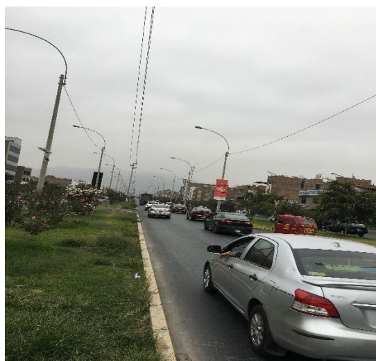
Figura 2. Av. Carlos Izaguirre – Transitabilidad vehicular
