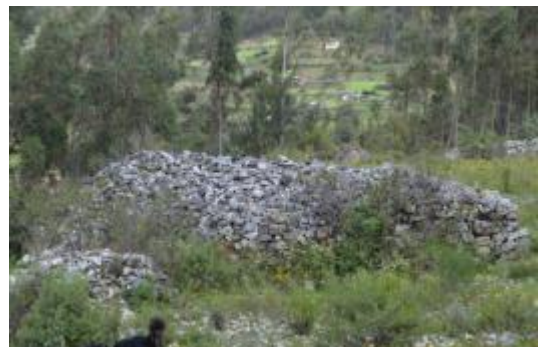
Muro de las ruinas de Poblazón
