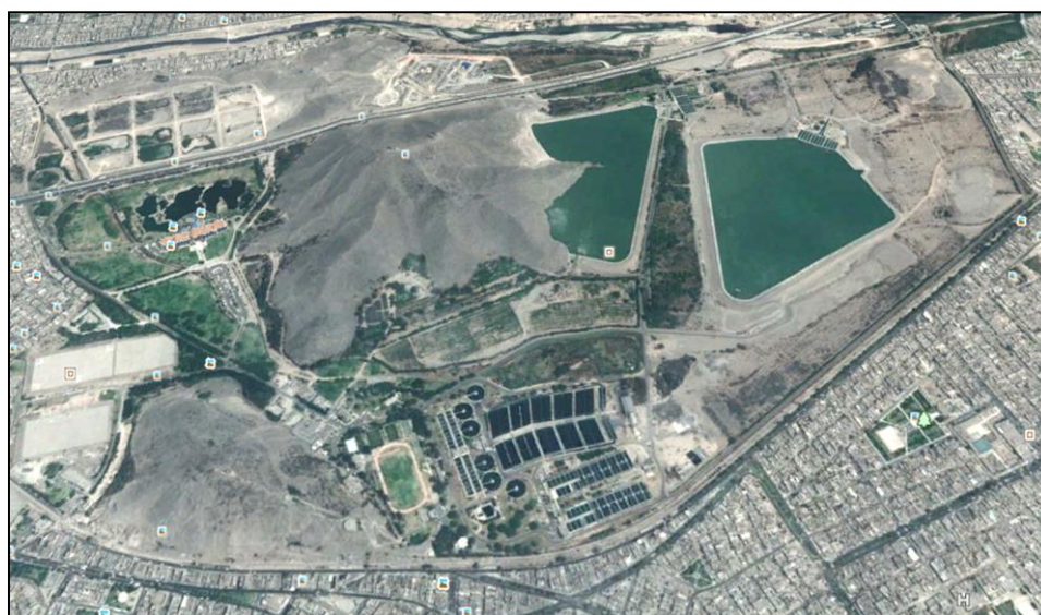
Figura 30. Reservorio de Sedapal.
