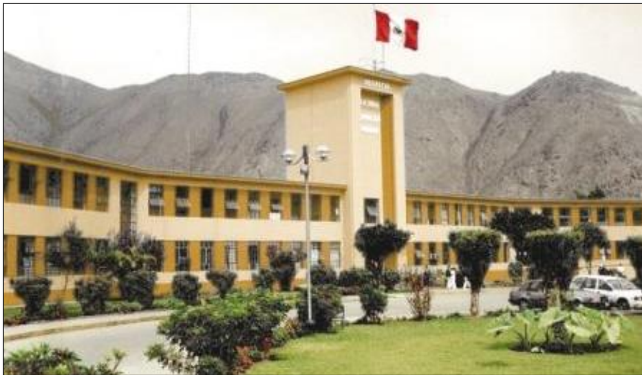
Figura 34. Hospital Nacional Hipólito Unanue.
