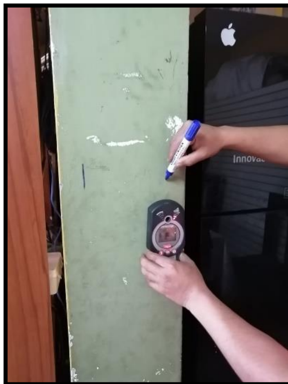
Foto N° 6 Calicata N° detector de acero
