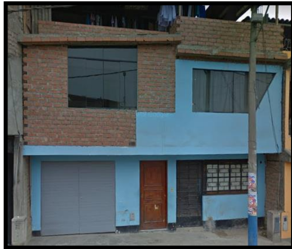
Figura 19: Muros portantes de ladrillo pandereta.
